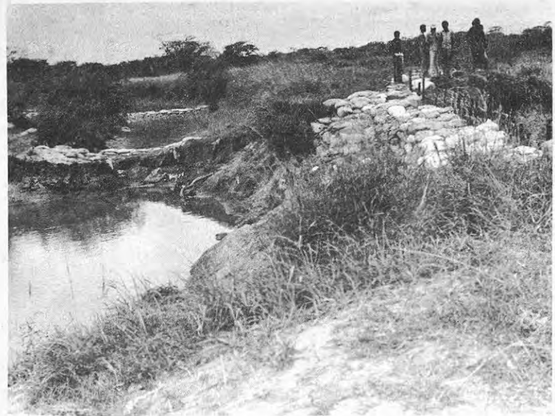
Jawaanno ciid lagu buuxiyey iyo silig ayaa aad loogu isticmaalay joojinta daadadka
