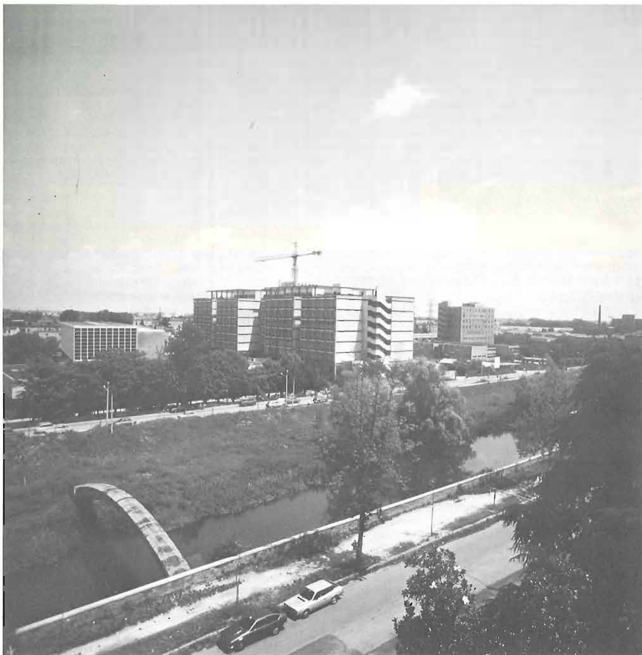
La Mensa universitaria, il dipartimento biologico e il dipartimento macchine
