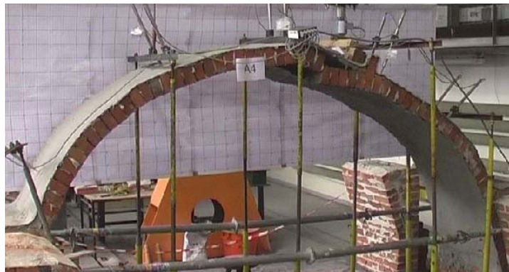
Figura 2.4 prove su archi in muratura rinforzati con CFRCM (Jasienko et al. 2009)
