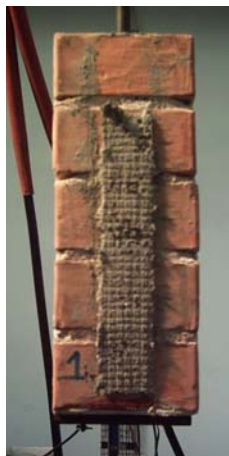
Figura 4.4 delaminazione mista C) D) tra muratura e SRG
