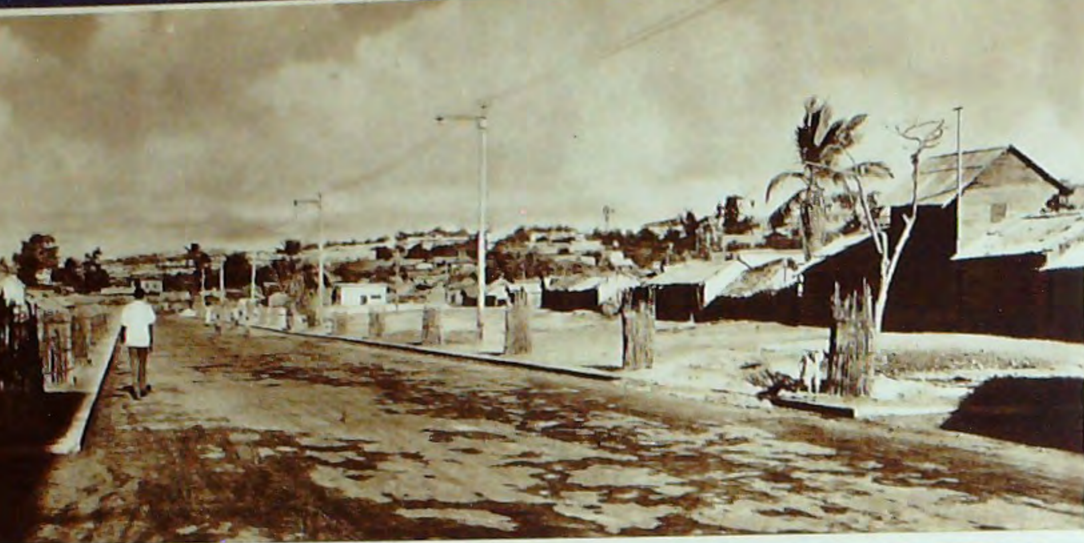
Assainissement du quartier El Gab: nouvelle rue asphaltée «Via Philippine»
