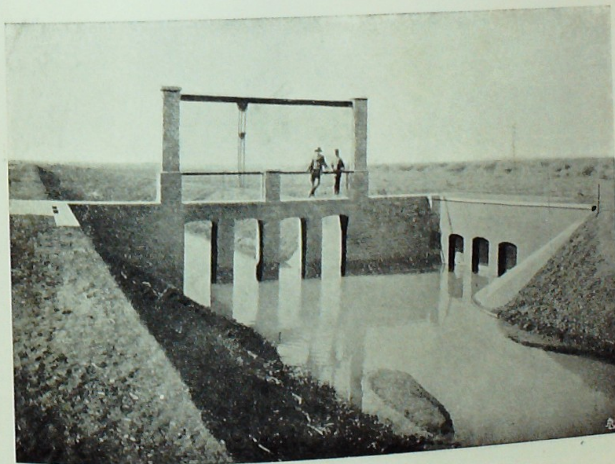
Sistema di prese su di un canale irriguo.
