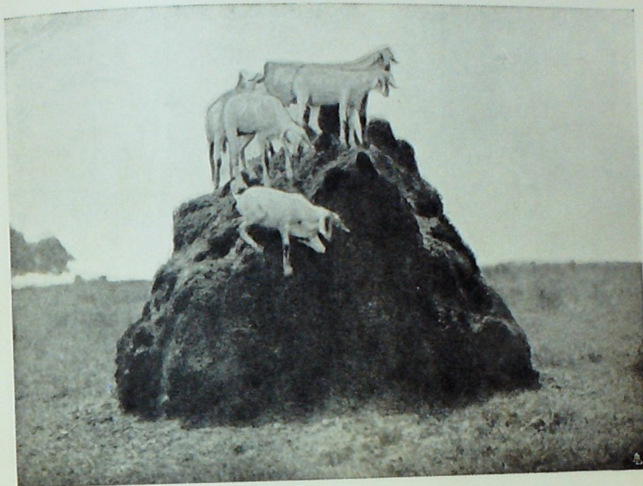
Un termitaio prima della demolizione.
