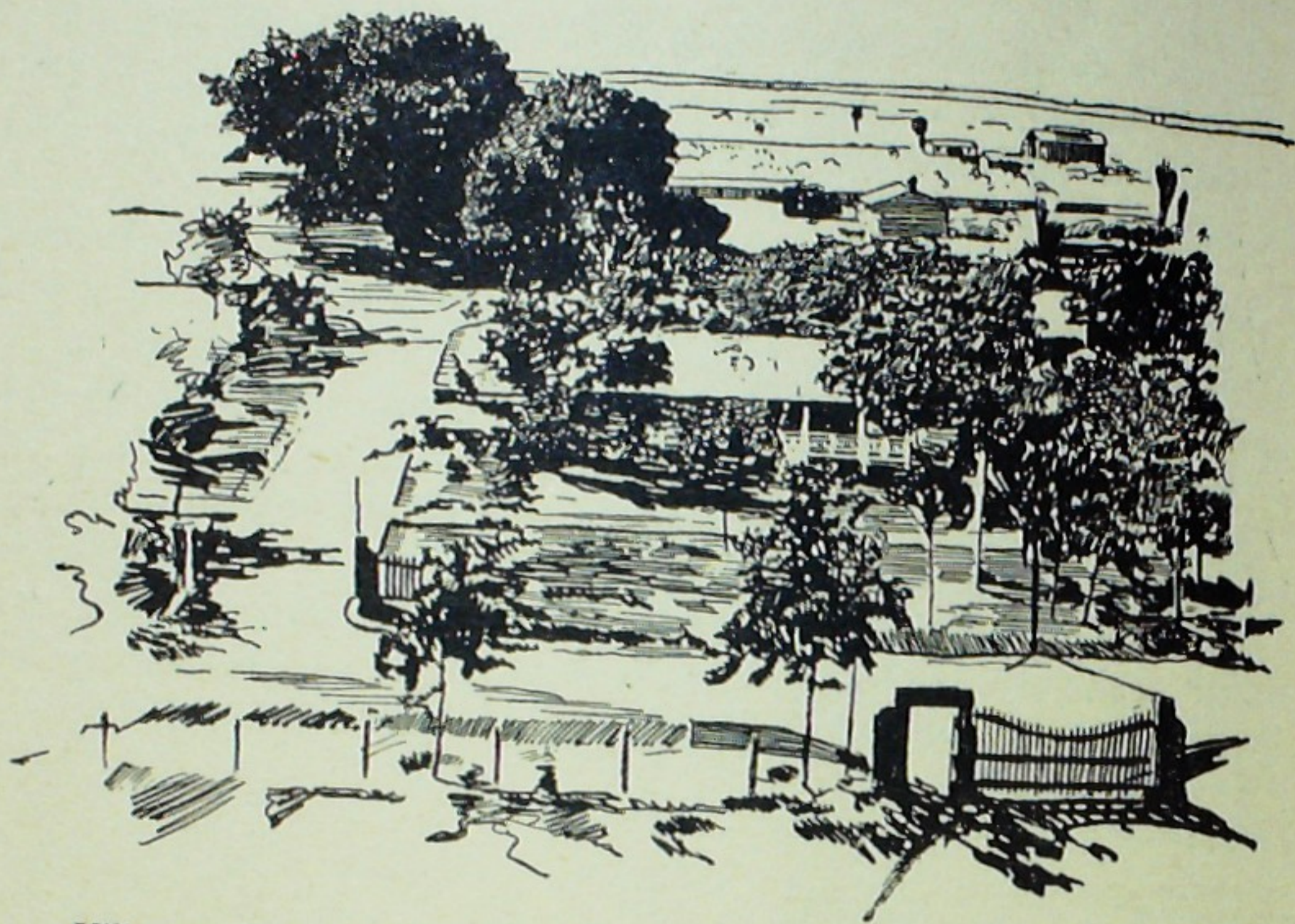
Villaggio Duca degli Abruzzi. L'ingresso principale alla S. A. I. S.
