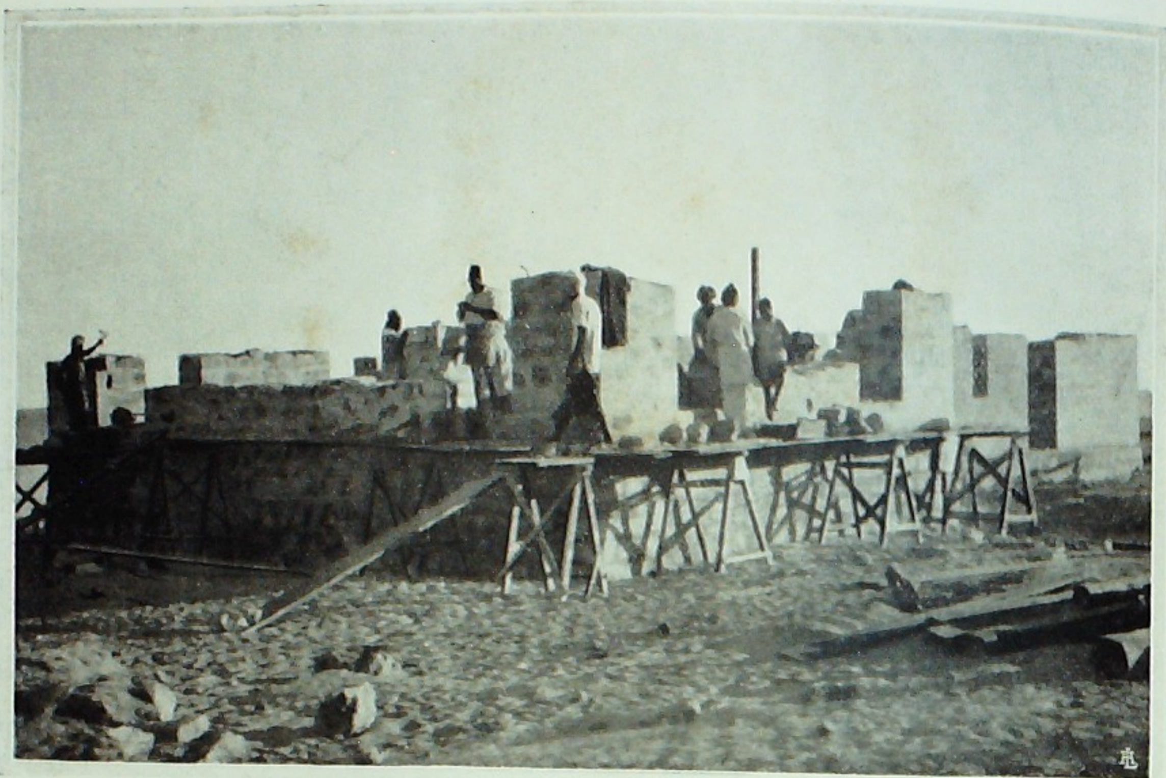
Ospedale in costruzione ad Alula
