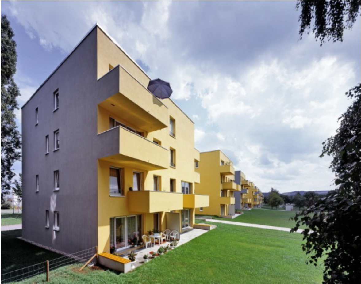
Quartiere edilizia sociale a Leinefelde, Germania, realizzato dall'architetto Stefan Forster. In questo caso sono stati effettuati interventi di demolizioni selettive, realizzate nuove aperture, un ampliamento delle facciate con l'addizione di balconi.
