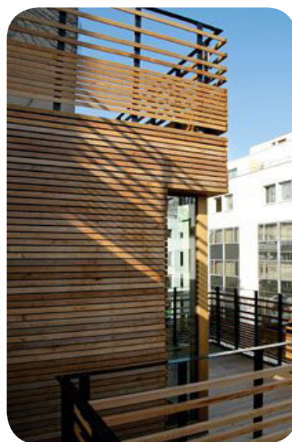
Sopra, particolare del rivestimento esterno.
