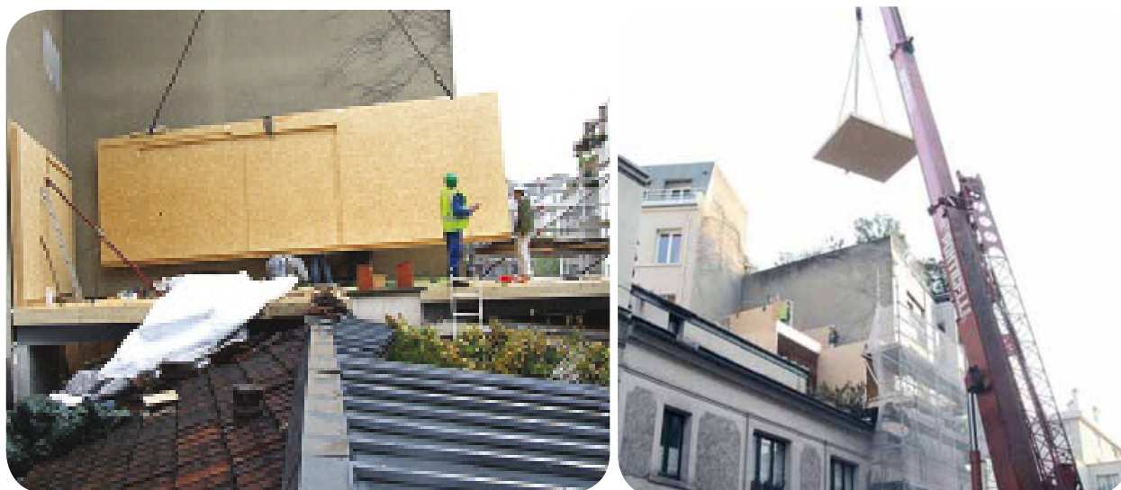
Immagini delle fasi costruttive.
