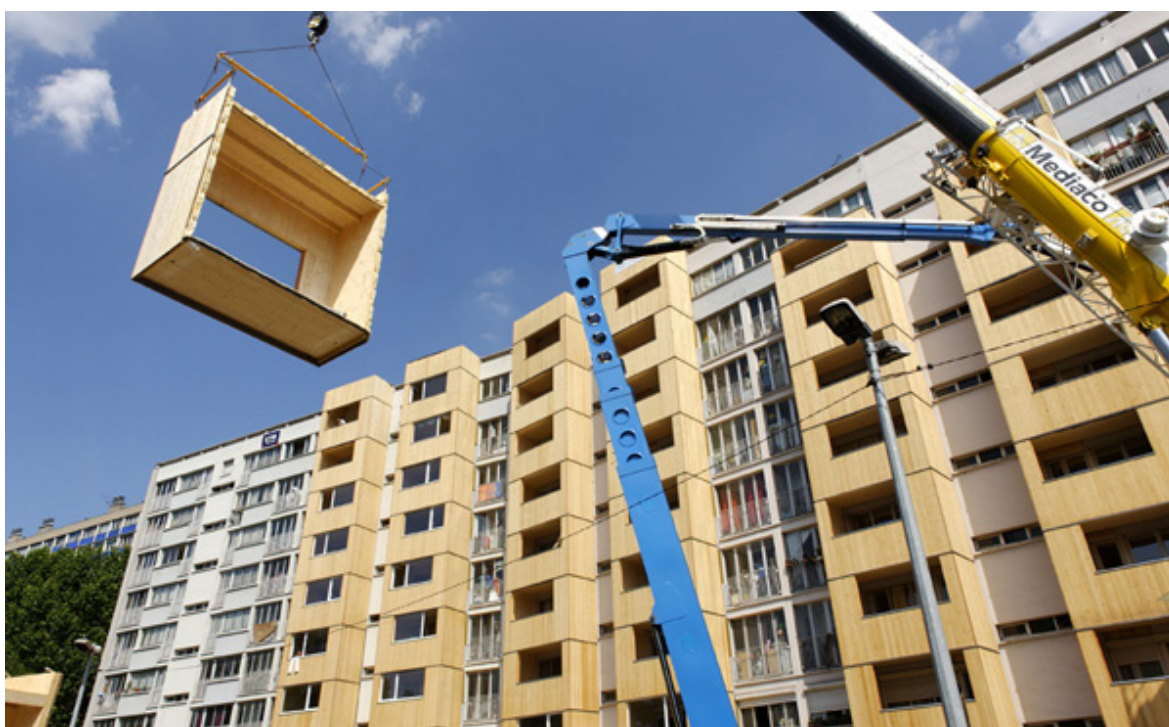
Loggias Bondy : progetto di Laurent Pillaud (Virtual architecture) per migliorare l'isolamento acustico della preesistenza. Estensione della preesistenza: addizione di singole unità di 6m 2 .
