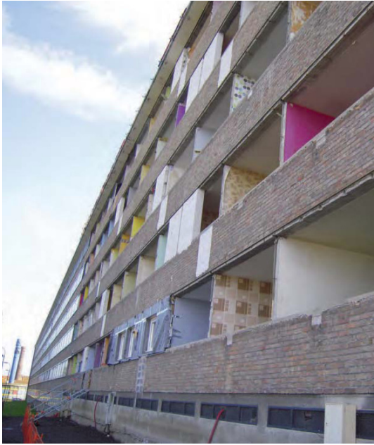
A sinistra: facciata sulla via J.B. Corot durante lo smantellamento dei pannelli in facciata. A destra: facciate prefabbricate per le aree soggiorno.
