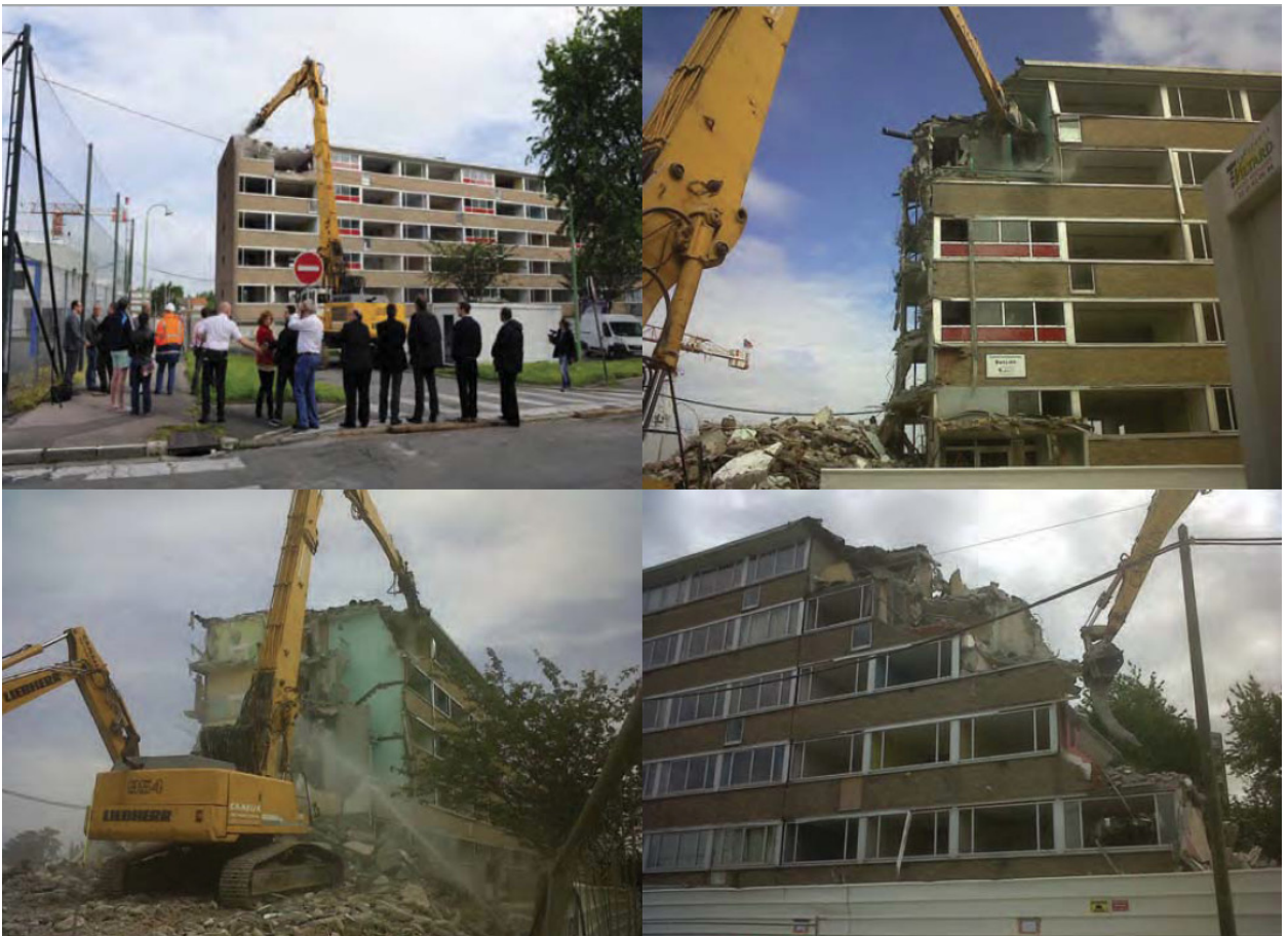
Sopra: vista della facciata dell'edificio prima dell'intervento. Sotto, il cantiere: le demolizioni parziali.
