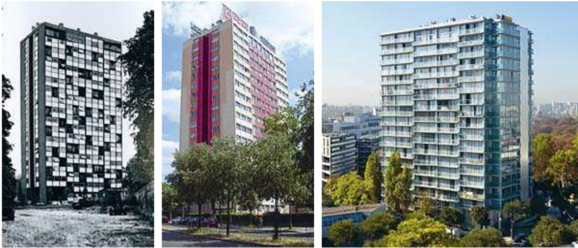
La torre Bois le Pretre. Il progetto originario, a sinistra, la prima riqualificazione degli anni '90, e, a destra, l'intervento di Druot, Lacaton e Vassal.
