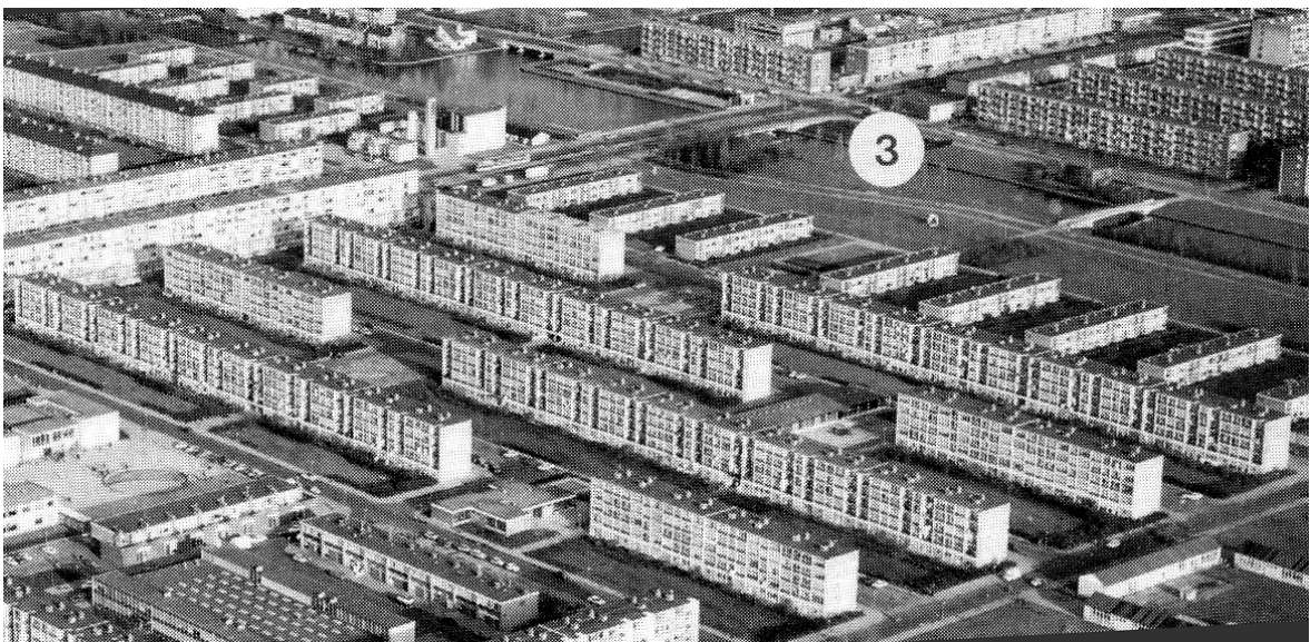
Complex 50 prima dell'intervento. Fonte Van Schagen architecten.
