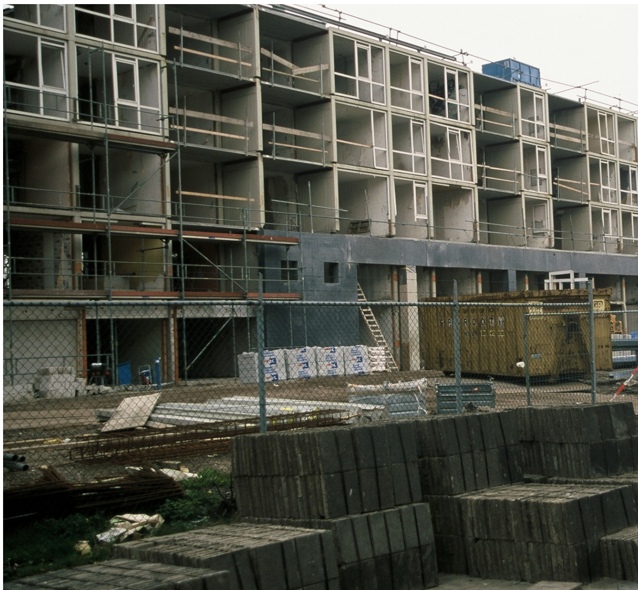
Vista del cantiere.
