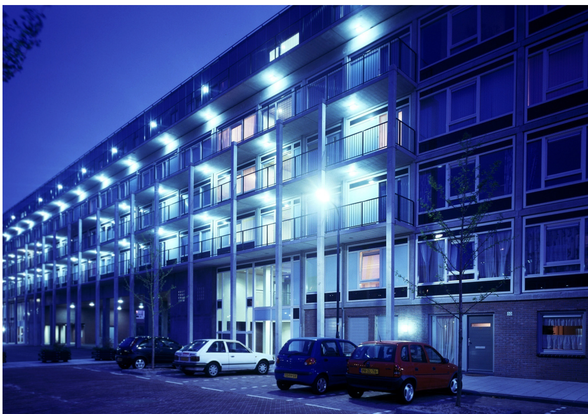
Complex 50 dopo l'intervento. Fonte Van Schagen architecten.
