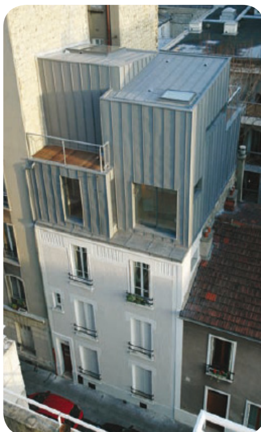
A lato: vista dell'intero edificio dopo l'intervento.
