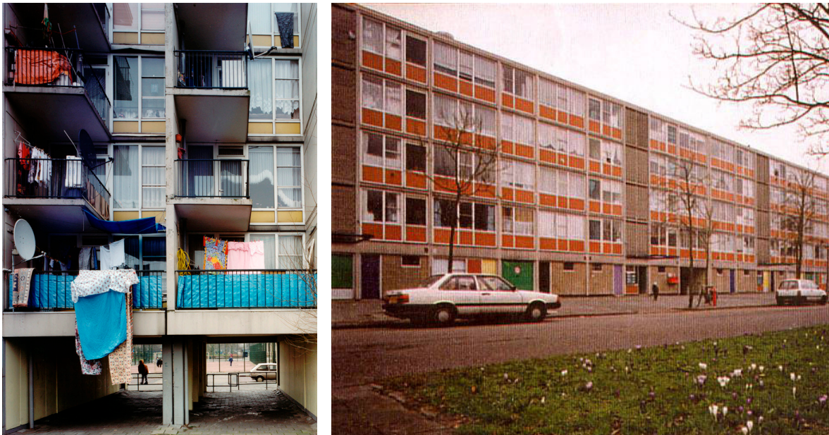
Complex 50 prima dell'intervento. Fonte Van Schagen architecten.
