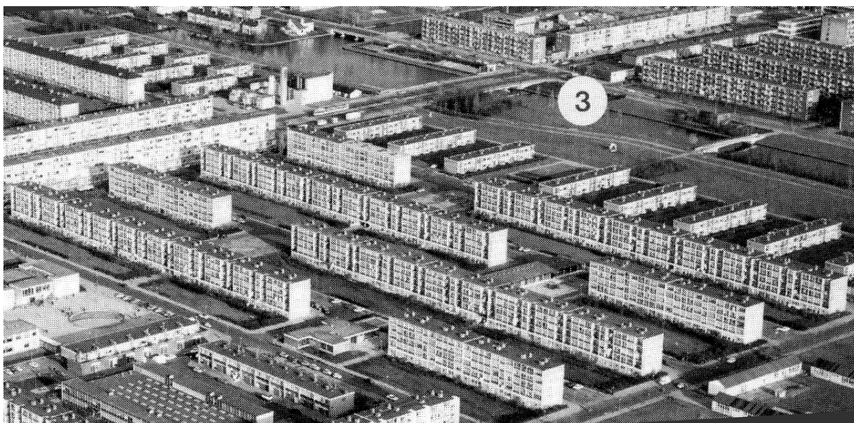
Vista dell'area prima dell'intervento.
