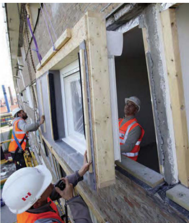
A destra e sotto: montaggio facciata. Sotto, a destra, pannello prefabbricato.
