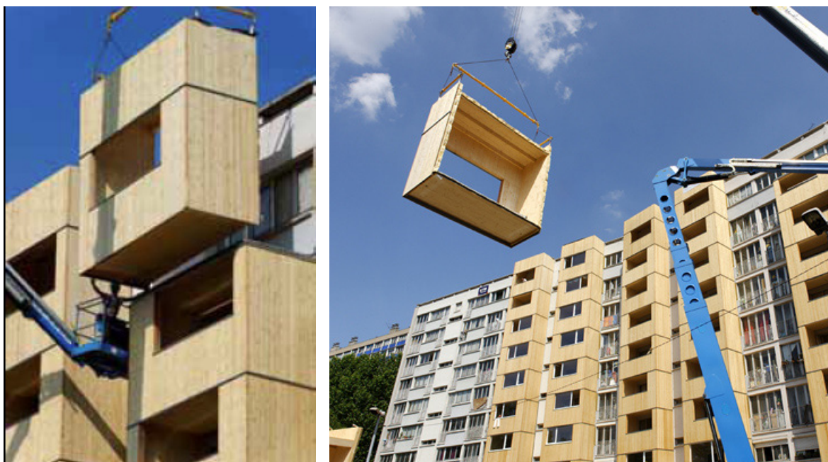
Posa in opera dei moduli-loggia dell'intervento Loggias Bondy.
