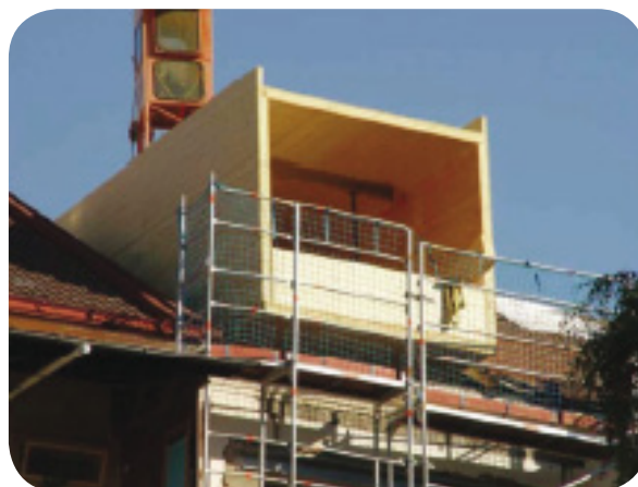
Fase del cantiere.
