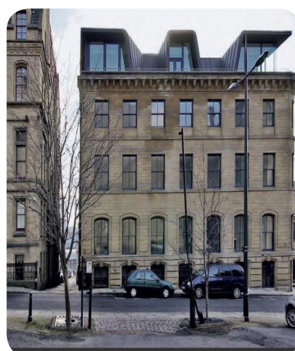
sopra: il guscio strutturale di Hannover house. Sotto, vista del complesso.
