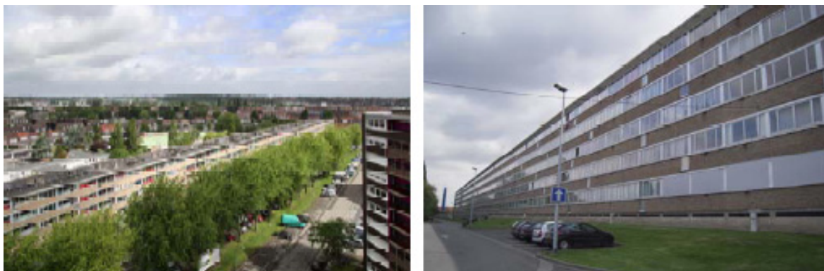
L'edificio Euclide prima dell'intervento (fonte: www.prebat.net )
