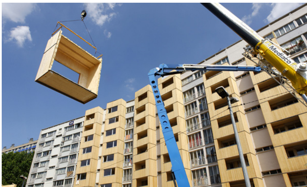
Posizionamento degli elementi- loggia in facciata.
