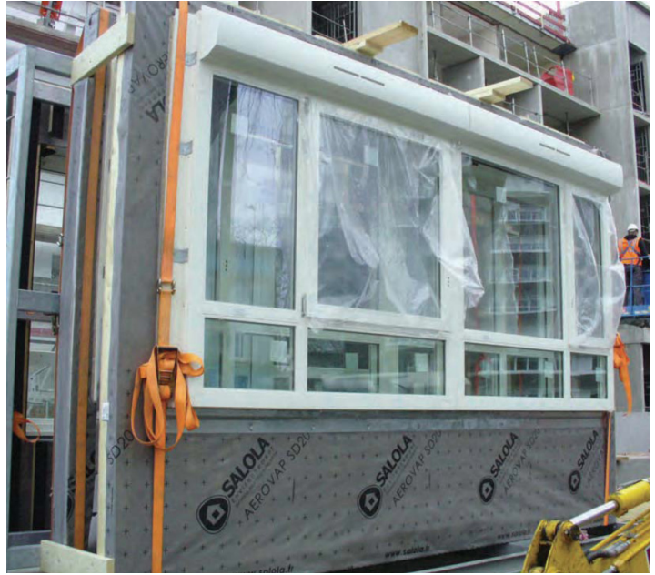
A sinistra: facciata sulla via J.B. Corot durante lo smantellamento dei pannelli in facciata. A destra: facciate prefabbricate per le aree soggiorno.
