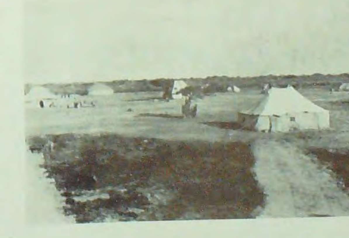
Dall'alto in basso: Case per impiegati somali dell'A.F.I.S. (Impresa Gulinelli e C.). - Ricostruzione della Garegis di Itala (Impresa Rambelli) - Pozzo di acqua potabile El Dah (El Bur) (Impresa Rambelli) - Cantiere Rambelli o Ortokoi.
