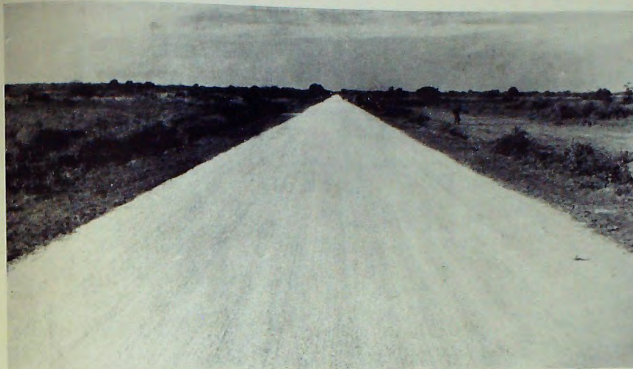
Strada Bolad - Villabruzzi - Ricostruzione e bitumatura (Impresa Manca)
