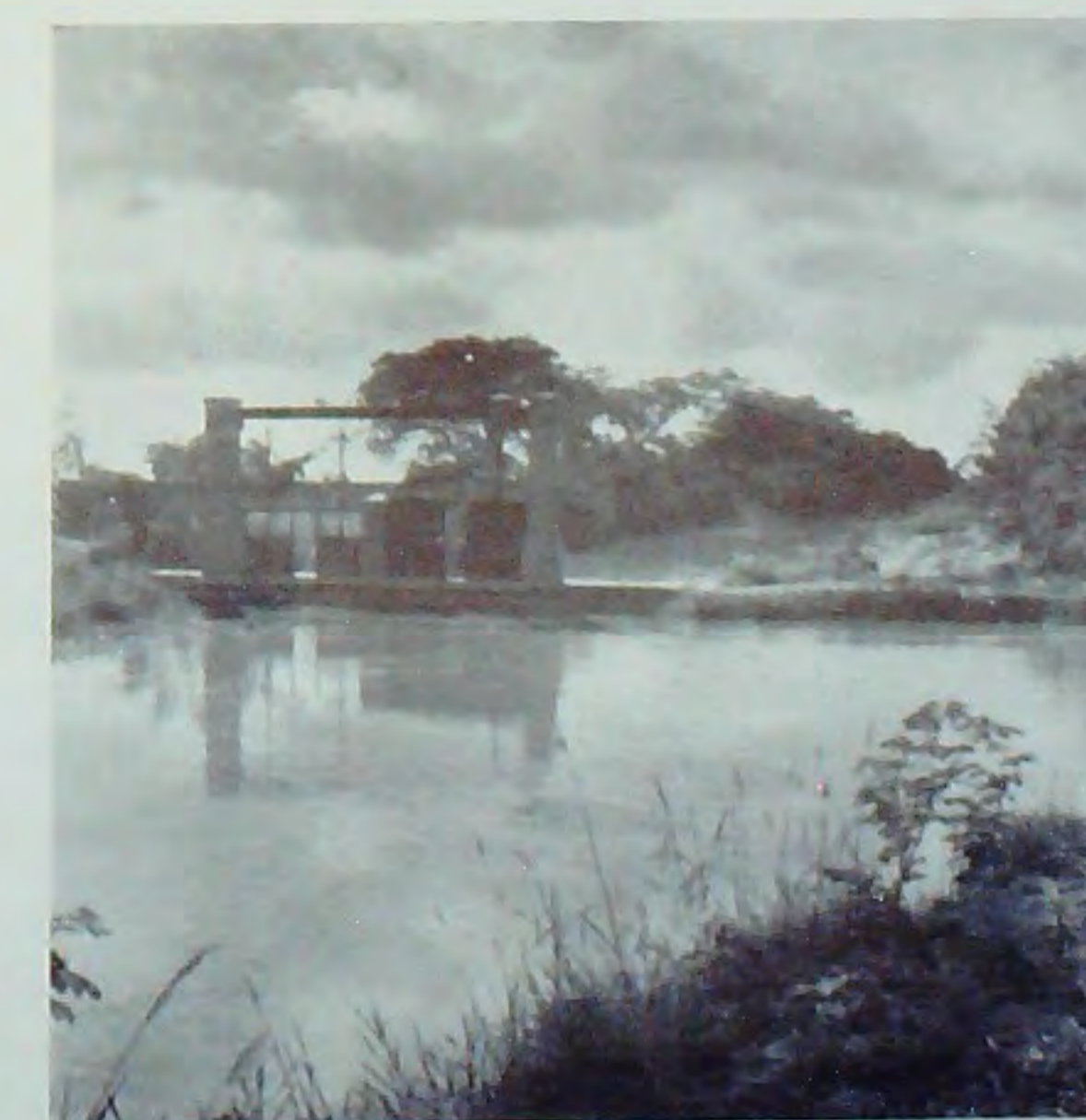
Chiusa all'imbocco del canale principale.
