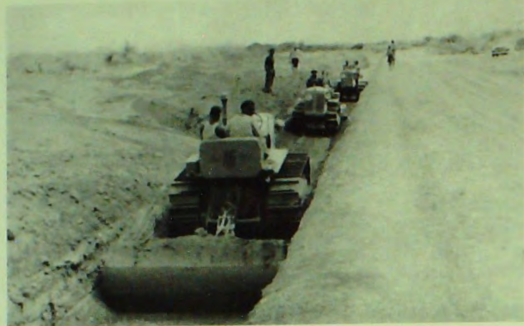
Lavori di escavazione Conole Osbole.
