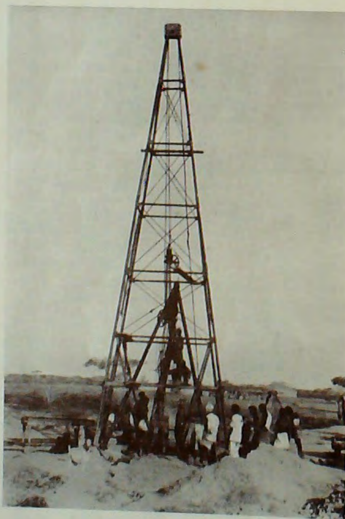
Trivellazione di pozzo
