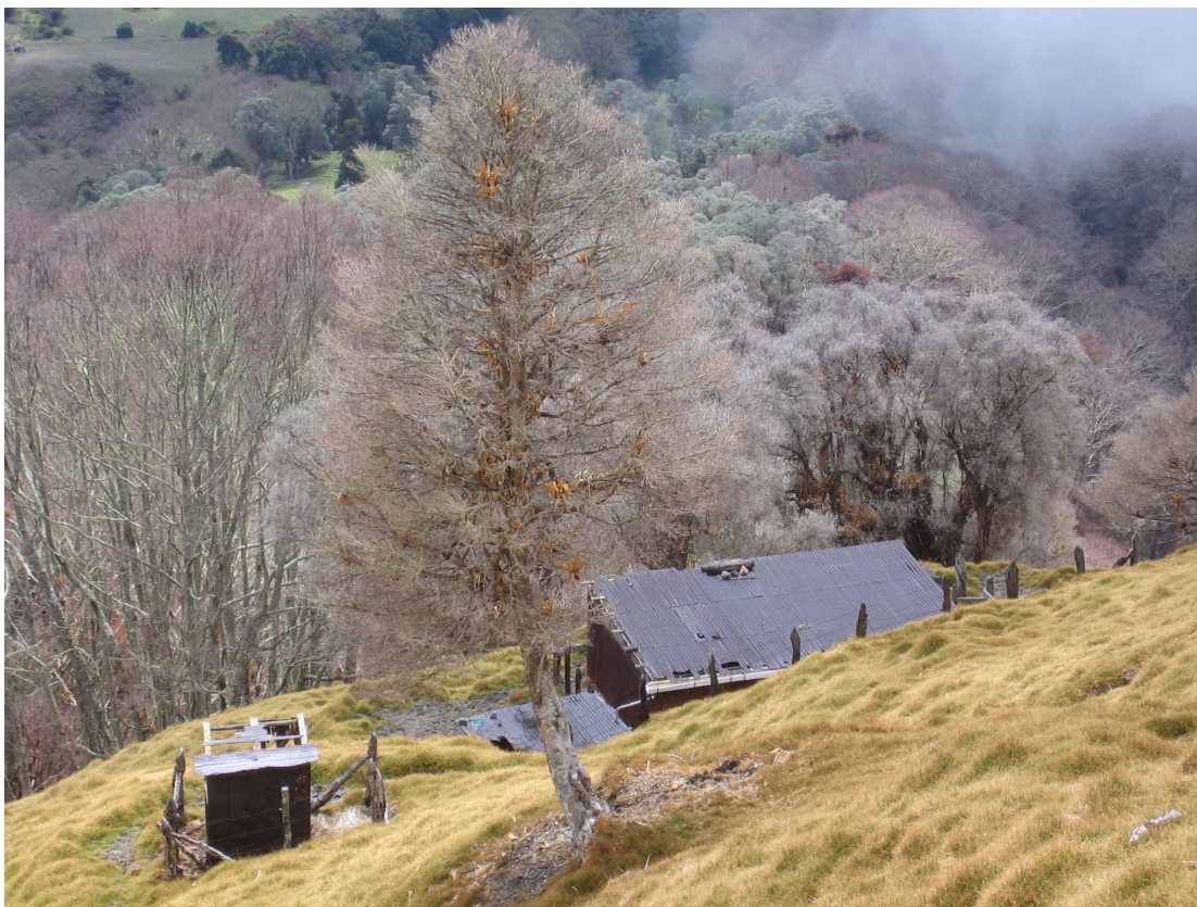
Fig.5.27. Stalla abbandonata con tetto corroso dai gas acidi dalla plume e sullo sfondo si possono osservare gli alberi morti.
