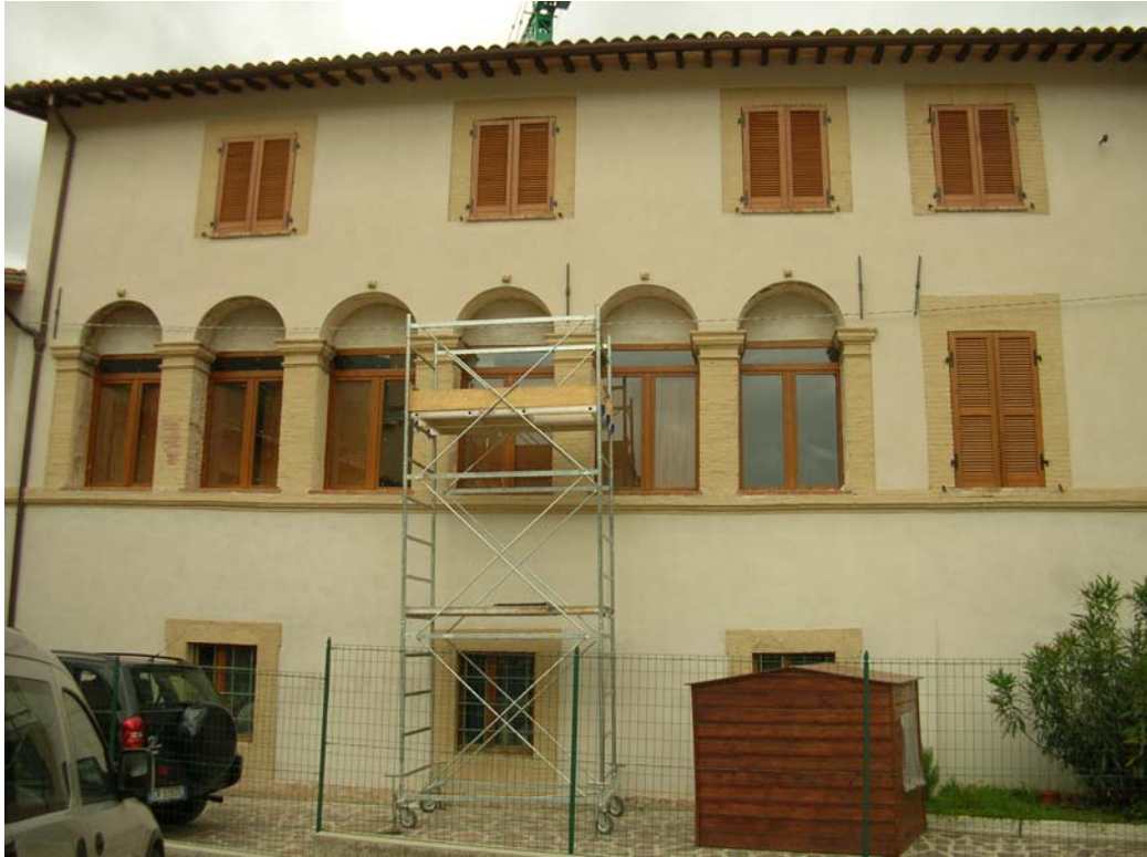
4.11. Belfiore, Palazzo degli Unti, il loggiato durante il restauro
