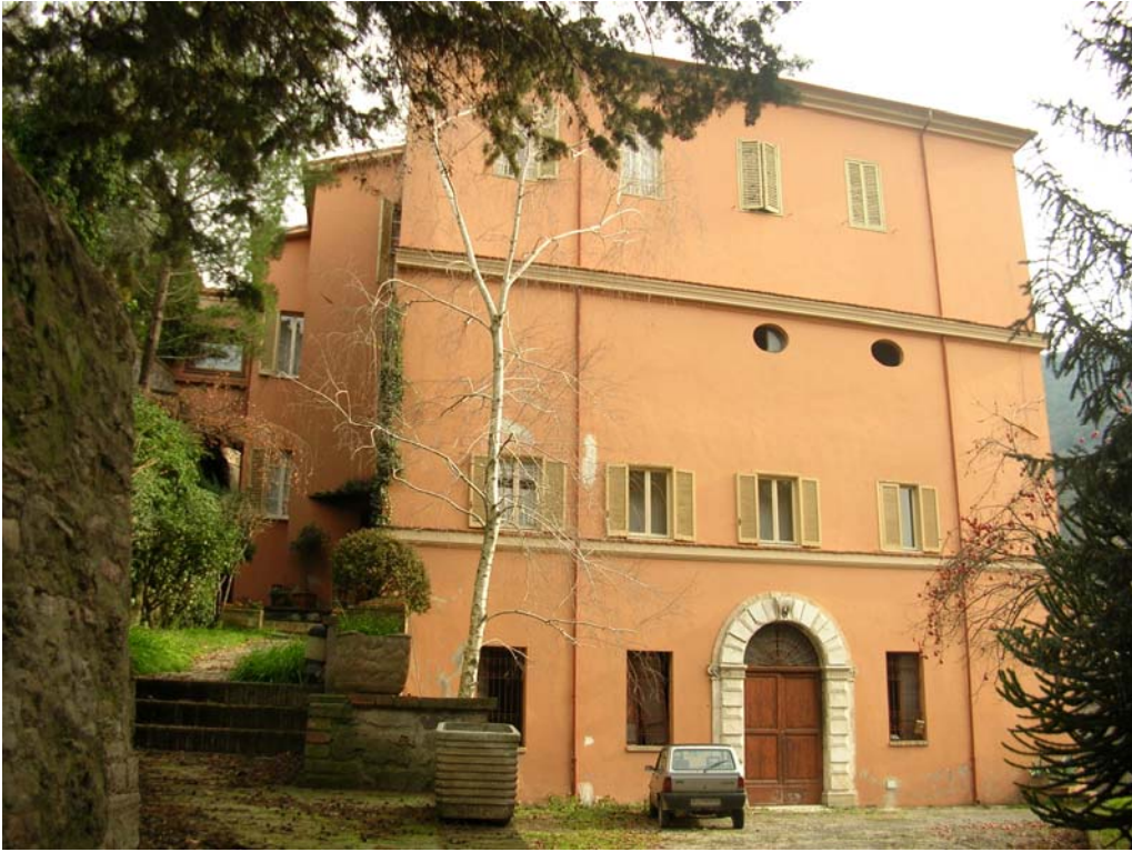
8.1. Villa Graziani (ex Castelli), attuale ingresso principale sul lato ovest
