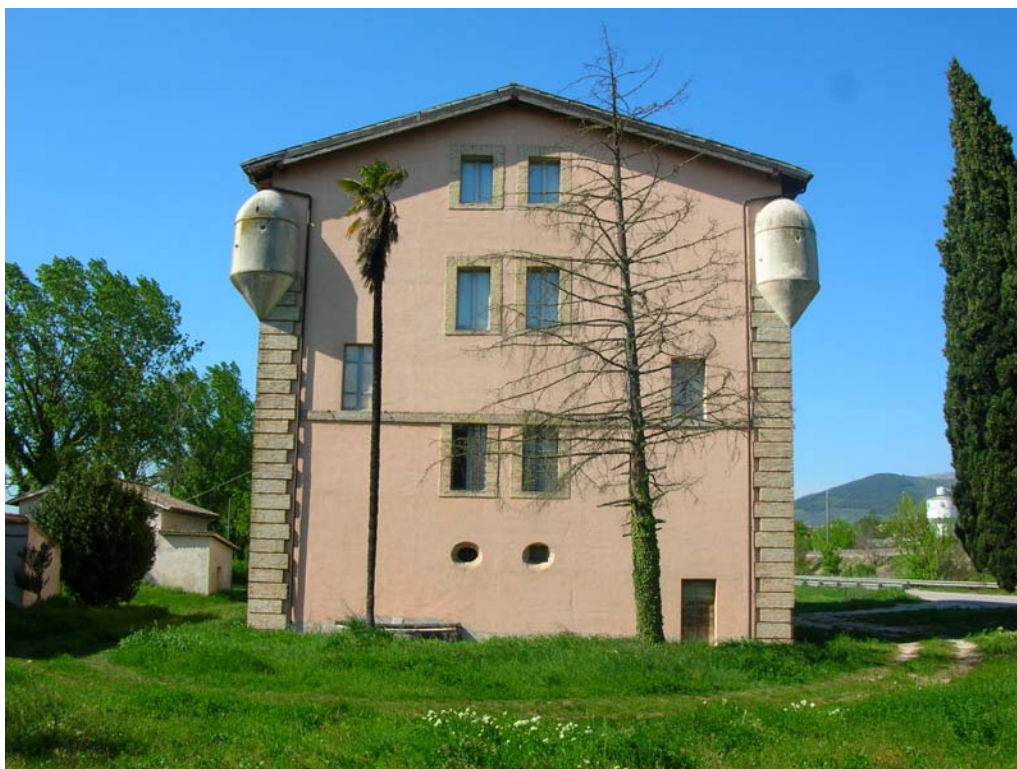
5.18. La Faustana, prospetto laterale sud
