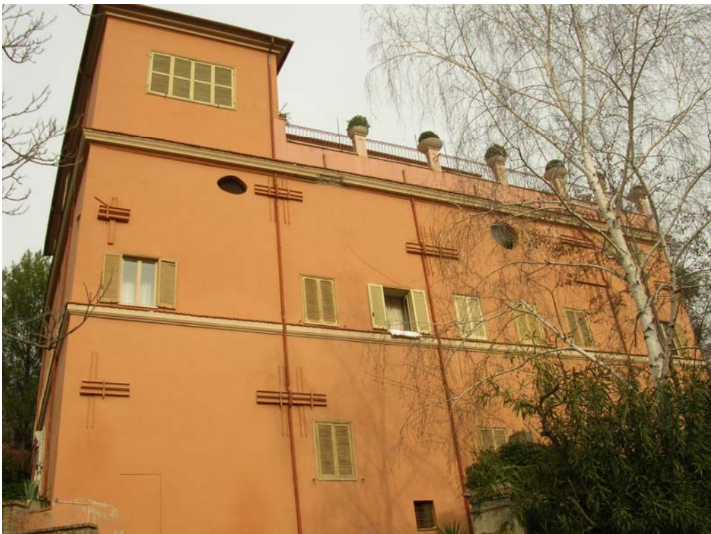
8.2. Villa Graziani (ex Castelli), fianco verso la valle sul lato sud
