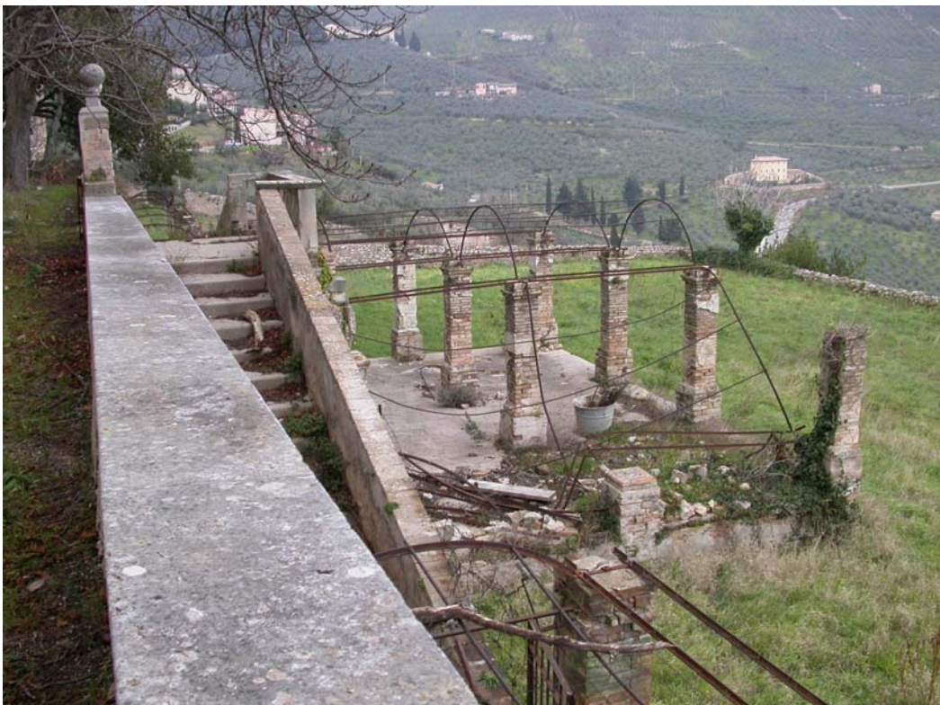
5.67. Villa Fabri, colonnato di fronte al ninfeo, prima dei restauri
