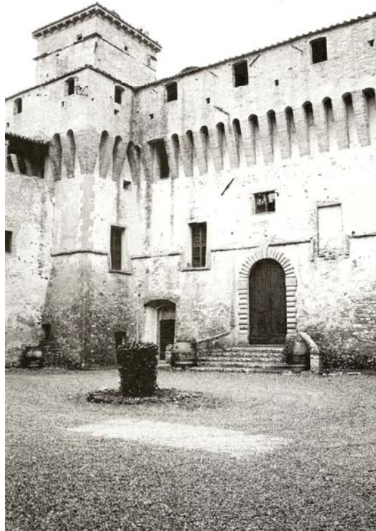
3.12. Civitella Ranieri, ingressi sulla facciata posteriore
