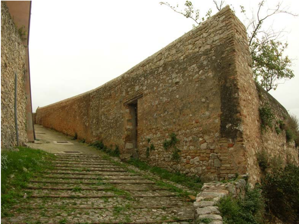
5.9. La Piaggia, strada e muro retrostanti il Palazzo del Collegetto
