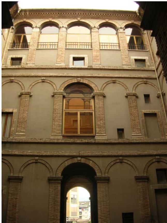
8.12. Palazzo Spada, cortile interno, lato est
