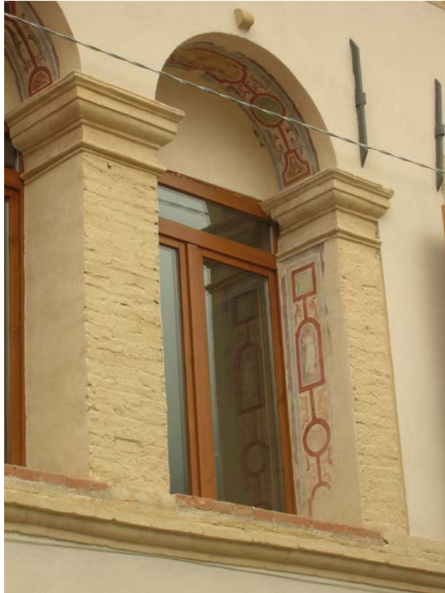
4.15. Belfiore, Palazzo degli Unti, decorazioni del loggiato dopo la pulitura
