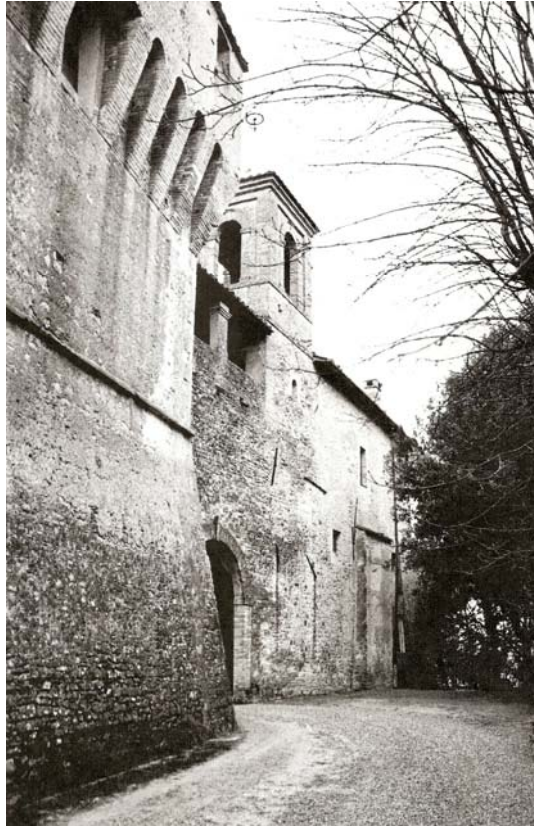
3.11. Civitella Ranieri, ingresso laterale destro
