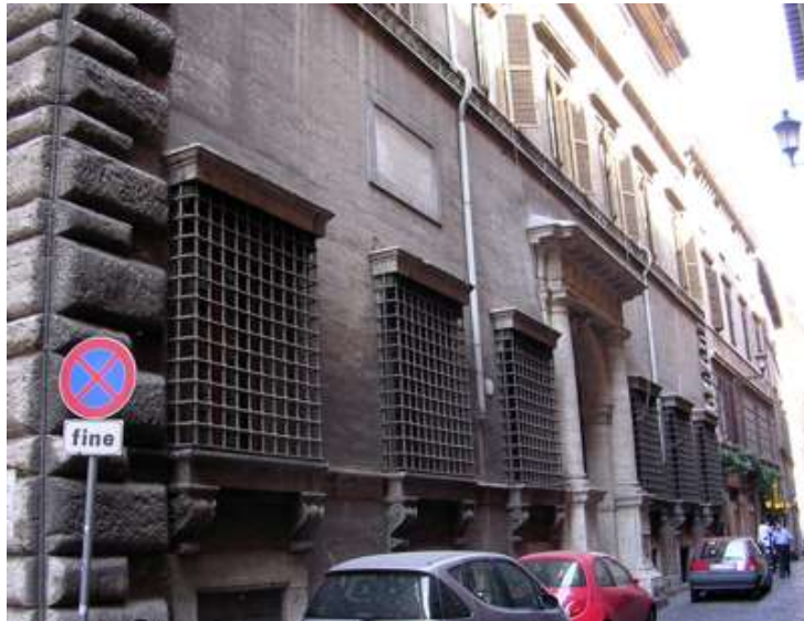
8.17. Roma, Palazzo Baldassini, facciata su via delle Coppelle
