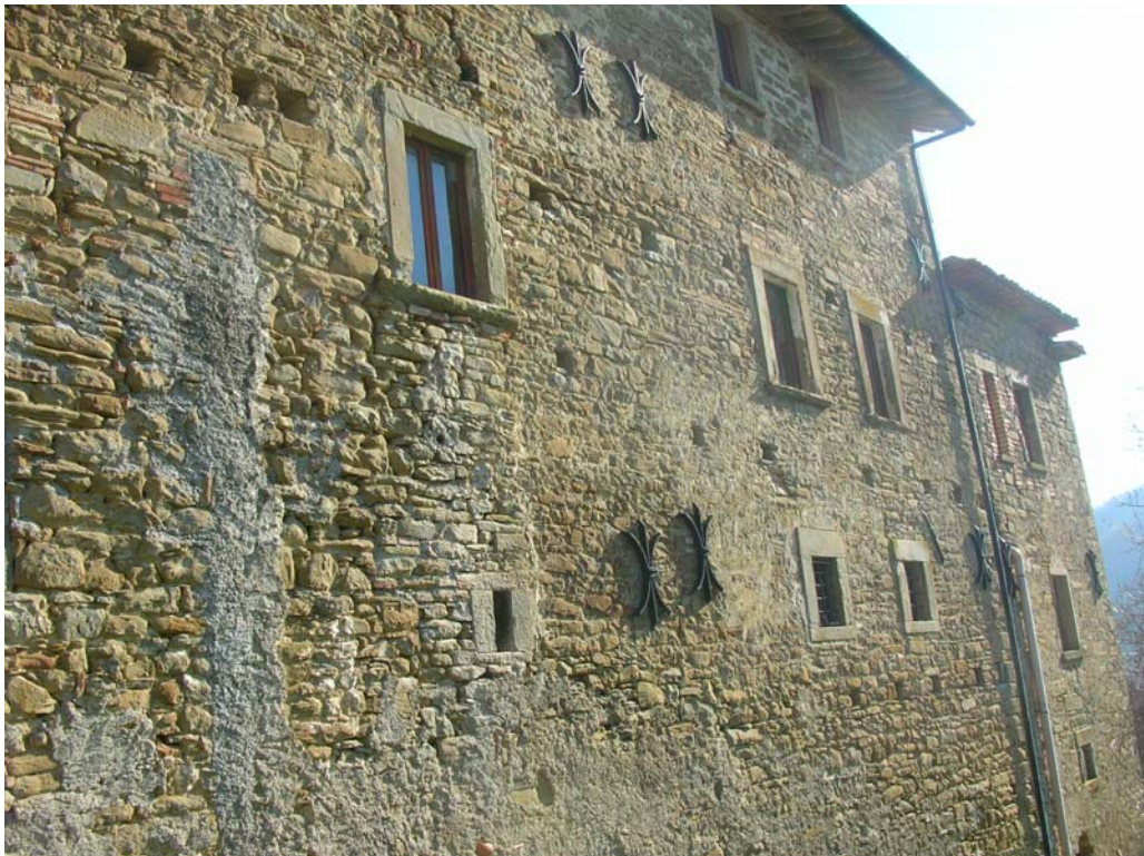
3.22. Campocolice, finestre del prospetto laterale
