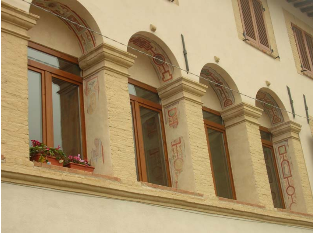
4.13. Belfiore, Palazzo degli Unti, il loggiato dopo il restauro
