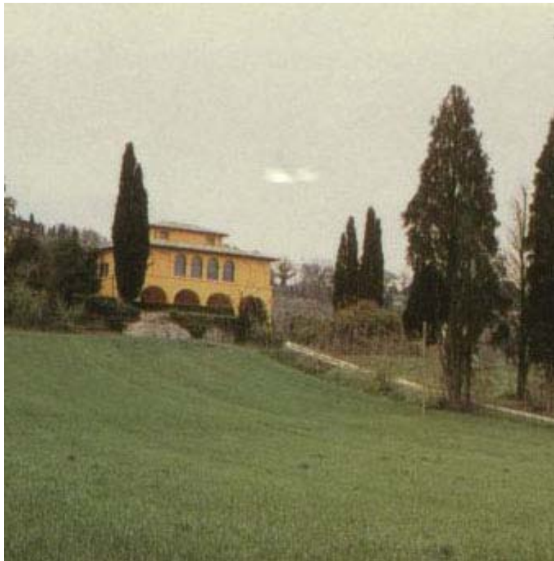
4.26. Villa I Portoni, veduta della facciata principale
