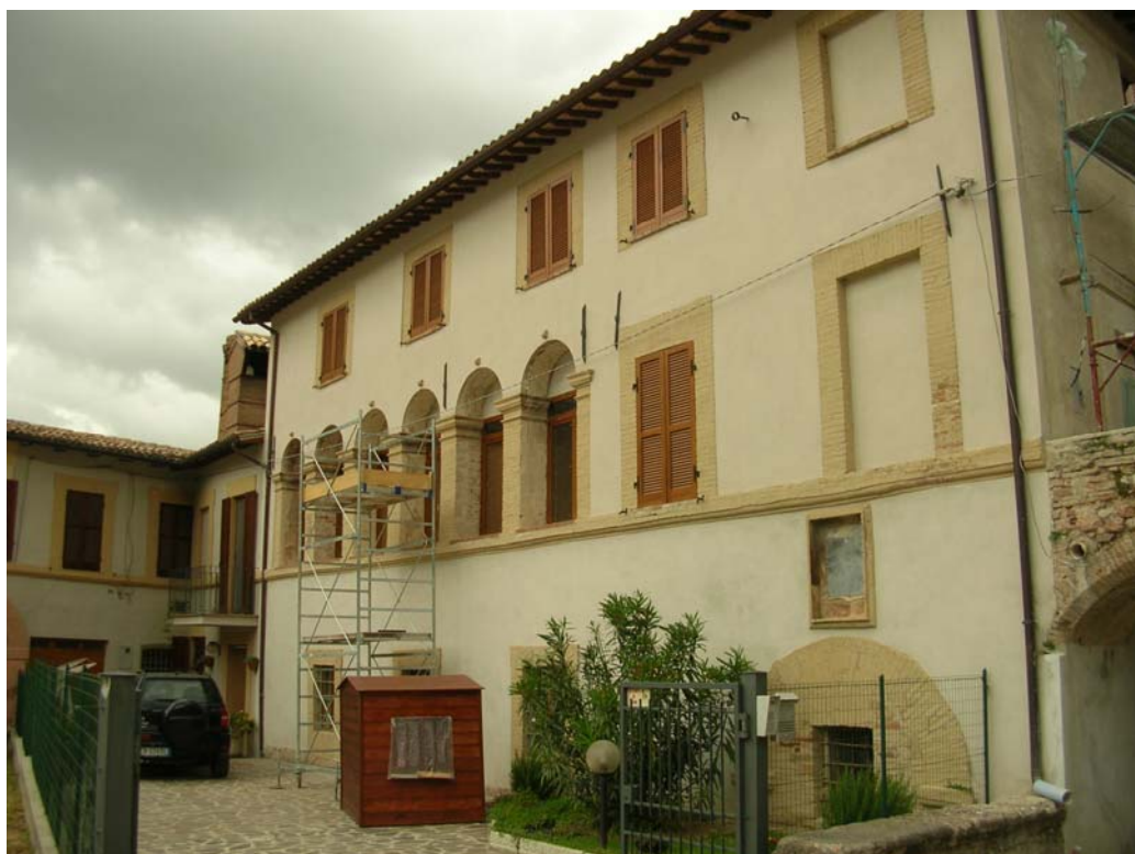
4.10. Belfiore, Palazzo degli Unti, il loggiato durante il restauro
