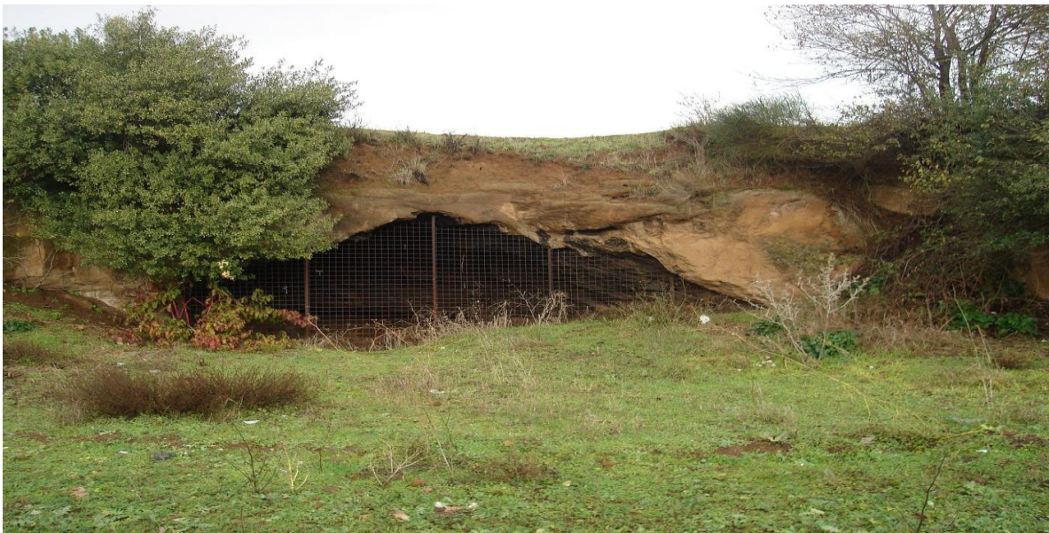
Figura 18: Entrata recintata di una cava abbandonata scavata nell'unità delle Pozzolane Rosse.
