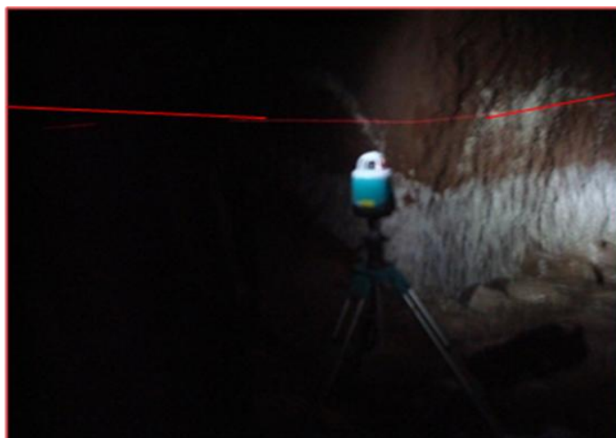
Figura 55: Utilizzo della livella laser all'interno della cavità.
