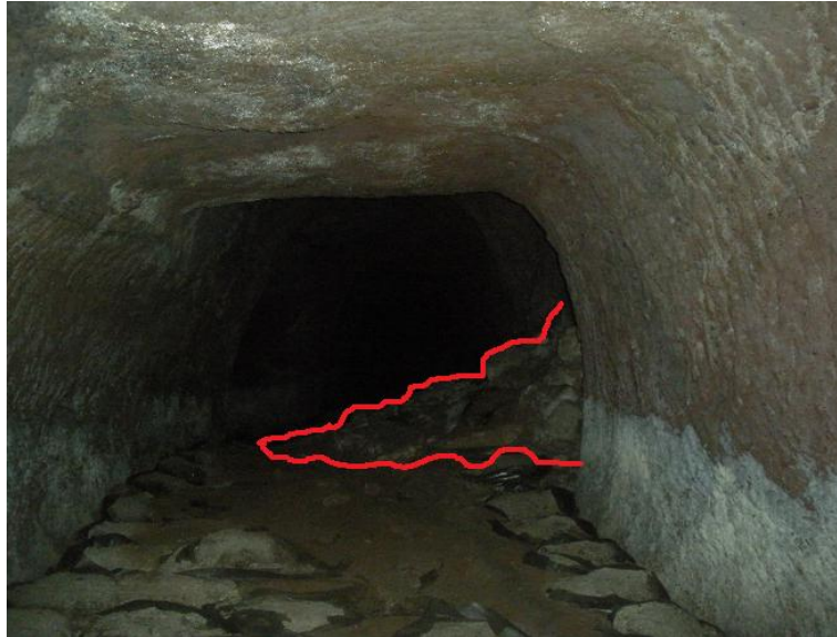
Figura 47: Immagine dell'interno della cavità, con evidenziato il materiale crollato da uno dei rami laterali. Sono ancora evidenti i sacchi di terriccio utilizzati per la coltivazione di funghi.
