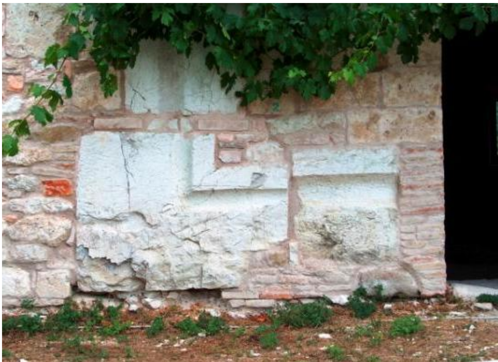
Fig.6.6 Un particolare della muratura del prospetto principale della chiesa di Santa Lucia. Si individuano chiaramente le lastre di reimpiego provenienti dall'adiacente edificio termale in rovina
