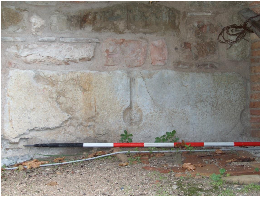
Fig. 6.12 Sedute di latrina reimpiegate nella muratura esterna della chiesa di Santa Lucia (Foto: R. Brinatti).
