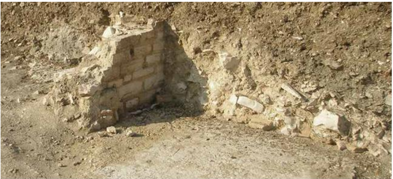
Fig. 5.4 Il muro di chiusura del portico Sud (US 20) e il suo crollo (US 26)
