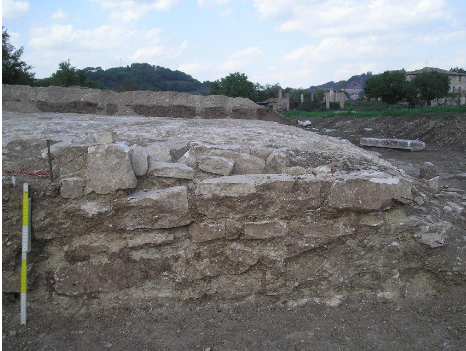
3.1 Il paramento del muro d'ala Sud (US 166)
