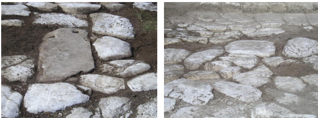
Fig. 5.10 Particolari del cardine massimo a Sud dell'incrocio col decumano massimo: nel primo dettaglio si nota l'impiego di un lastrone quadrangolare nel mezzo della carreggiata e una lacuna nel basolato, nella seconda si nota la posizione "sbagliata" di alcuni basoli rispetto alle linee di carro
