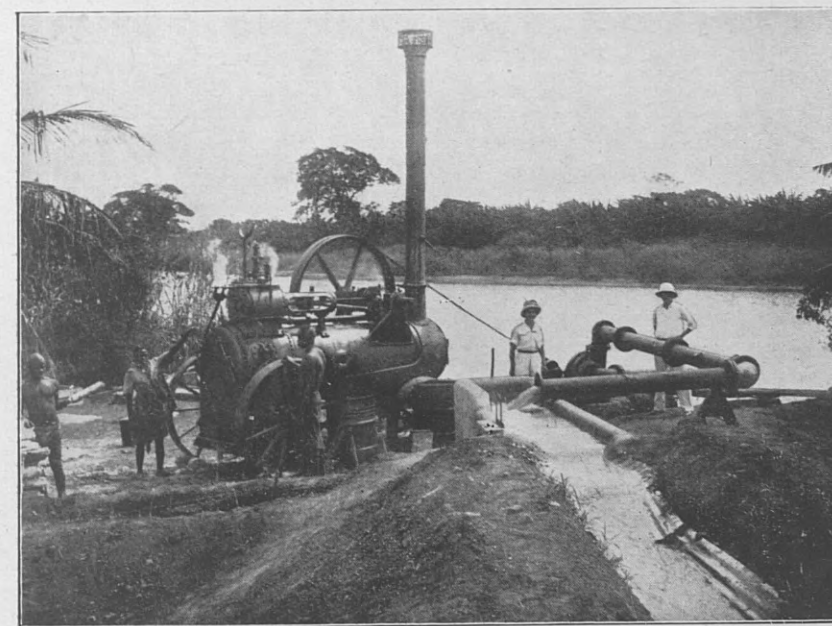
... una motopompa installata su una solida piattaforma ...
