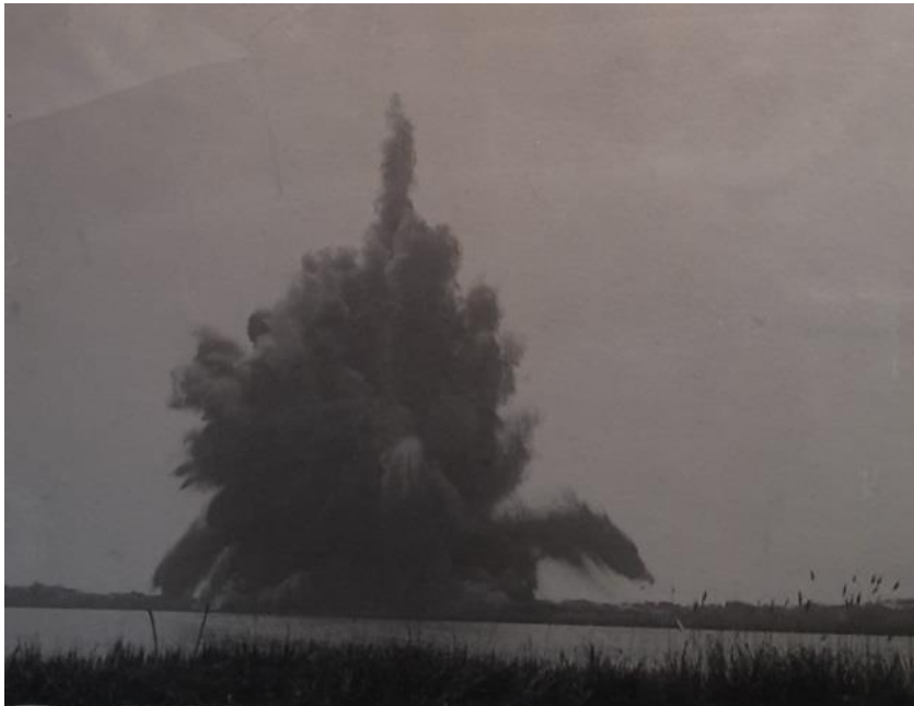
Fig. 54. Esplosione di una mina per l'apertura di un canale a Fogliano. Fonte: AC, Fondo fotografico, n. 35.
