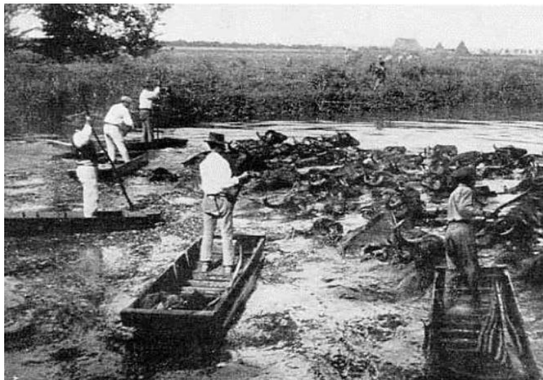
Fig. 31. Lo spurgo dei canali con i bufali spinti in acqua dai sandalari. Fonte: ASL, Consorzio di CBP.
