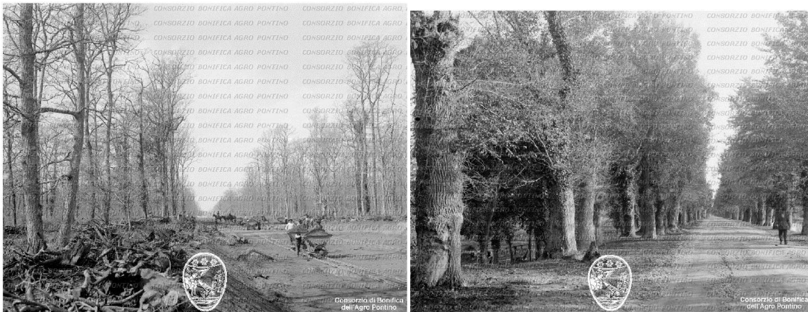
Figg. 67-68. Strada litoranea attraverso la selva di Terracina, lavoro di terra a decauville (13/03/1930), (a sinistra); via Appia presso Mesa (07/11/1929), (a destra).
