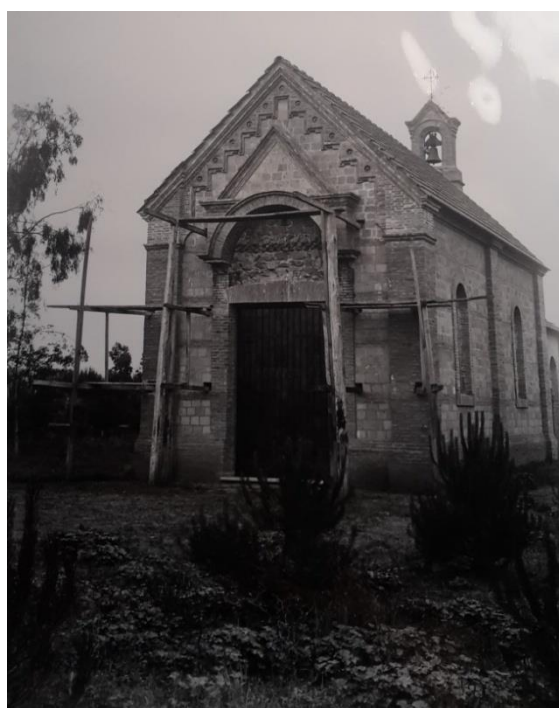
Neg. N. 639. Serie: Fogliano-parco; soggetto: la Chiesetta Inglese.
