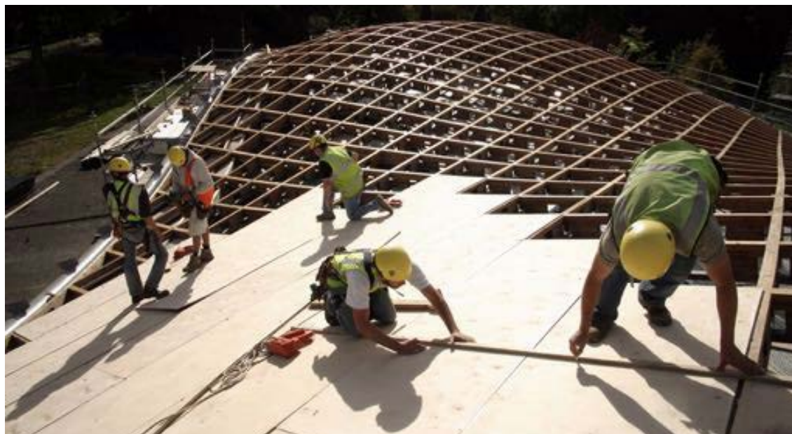
Fig. 2.45 – fasi di montaggio del sistema di controventamento
