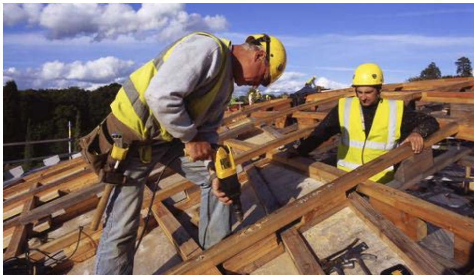
Fig. 2.44 – montaggio del corrente superiore della gridshell del Savill building
