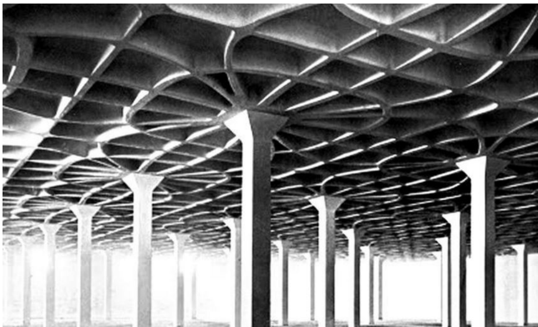
Fig. 2.23 – solaio nervato del Lanificio Gatti, Roma 1951
