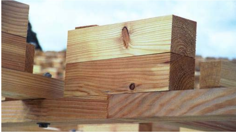
Fig. 2.43 – fase di assemblaggio della gridshell del Savill Building
