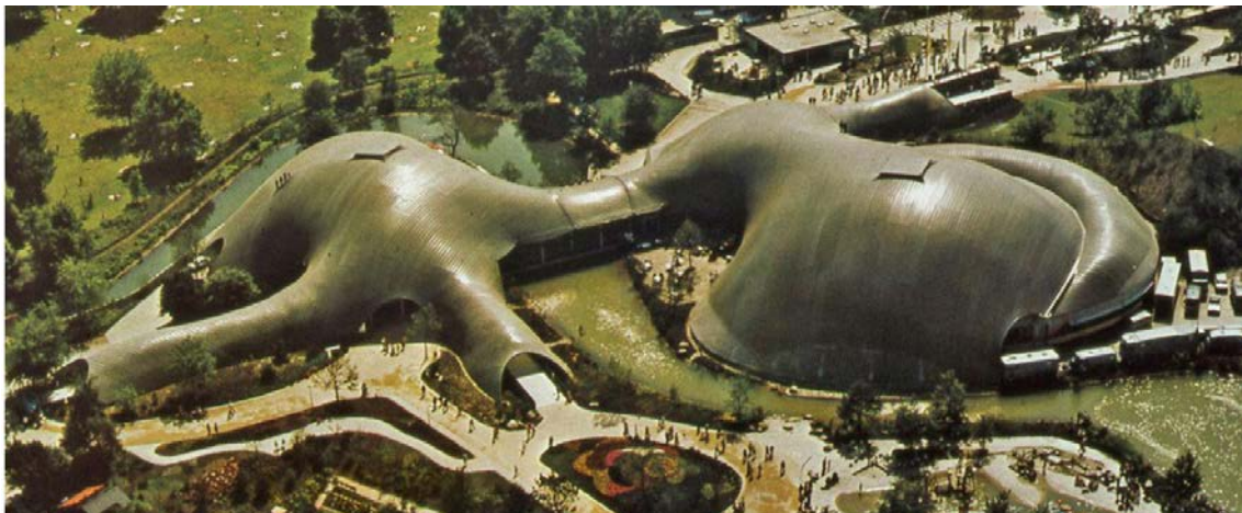
Fig. 2.29 - vista dall'alto della copertura della Mannheim Multihalle
