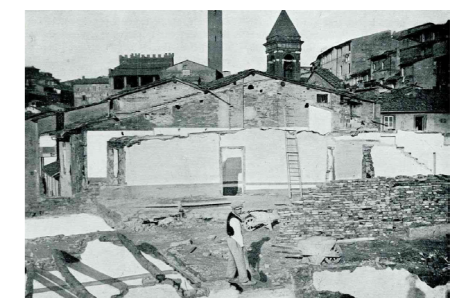
Siena, Lavori di demolizione al quartiere Salicotto, da CURTI (1931), p. 108-110
