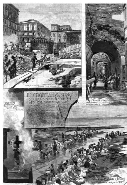
Napoli, I lavori per il risanamento, da "L'Illustrazione italiana", 1892
