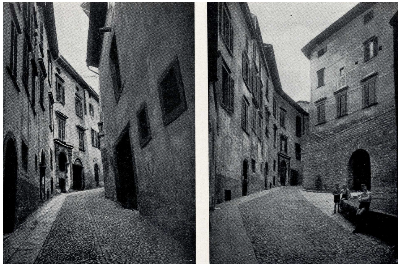
Bergamo, Sistemazione via Donizetti, lo stato dei luoghi prima e dopo l'intervento, da ANGELINI (1963), p. 81
