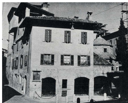
Bergamo, Restauro della Casa della Misericordia, lo stato dei luoghi prima e dopo l'intervento, da ANGELINI (1963), p. 112
