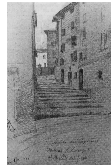
Bergamo, Vicolo nei pressi di via San Lorenzo prima delle demolizioni, 1888, da COMUNE DI BERGAMO (1989), p. 36
