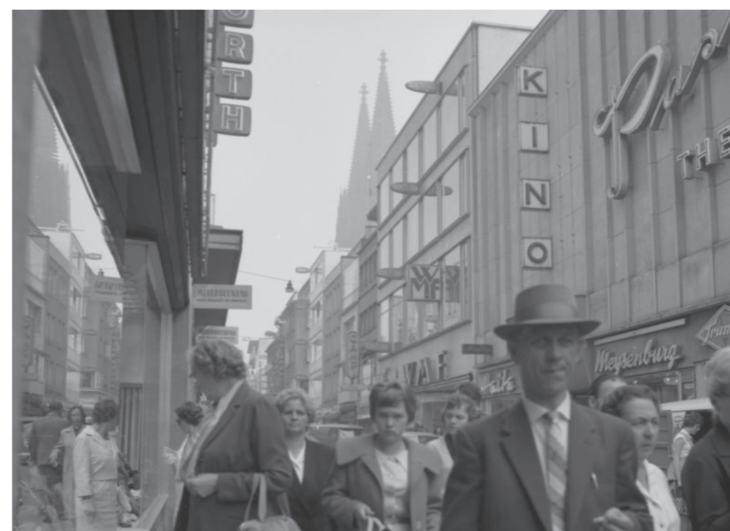
Fig. 5.42 Una vista dello stesso tratto della Hohe Straße di Colonia (fig. 5.40) dopo la ricostruzione, intorno alla metà degli anni '50; sullo sfondo, sempre le guglie del Duomo
