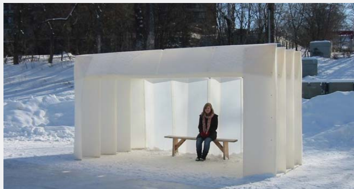
Corogami Folding Hut Progettista: Arch. David Penner Materiali: propilene ed elementi di fissaggio in ottone laminato
