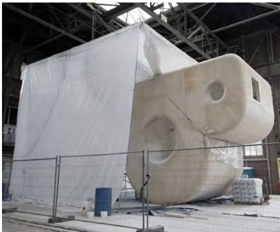
Processo di autoconstruzione di un singolo atelier
