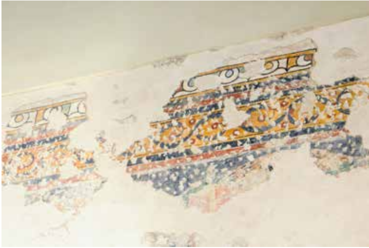
Fig. 2.269 Terracina, cattedrale di San Cesareo, navata destra, parete nord, fascione superiore . (2)
