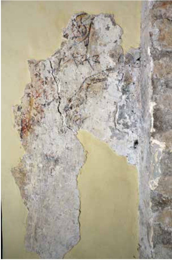
Fig. 2.17 Bassiano, chiesa di San Nicola, navata sinistra, terzo arco, piedritto destro, animali . (2)
