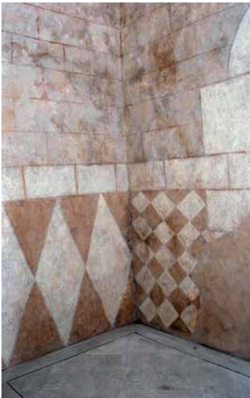
Fig. 2.39 Priverno, abbazia di Fossanova, cappella annessa all'infermeria dei monaci, finta cortina muraria e decorazione a losanghe.
