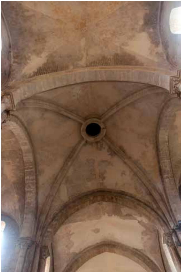
Fig. 2.36 Priverno, abbazia di Fossanova, chiesa, navata centrale, volte a crociera.
