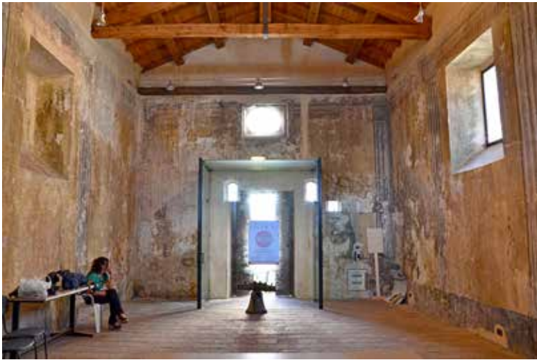
Fig. 2.1 Bassiano, chiesa di Santa Maria della Piazza, interno. (2)
