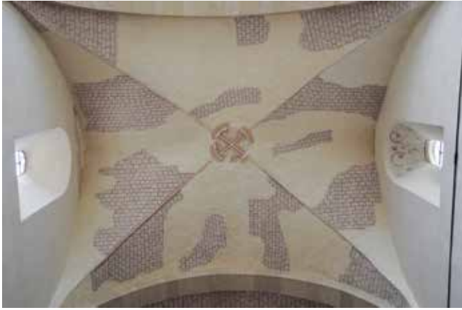
Fig. 2.253 Sermoneta, abbazia di Valvisciolo, chiesa, navata centrale, volta a crociera, finta cortina muraria . (2)
