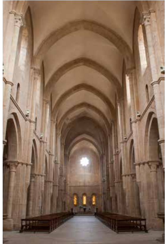
Fig. 2.35 Priverno, abbazia di Fossanova, chiesa, navata centrale, presbiterio.
