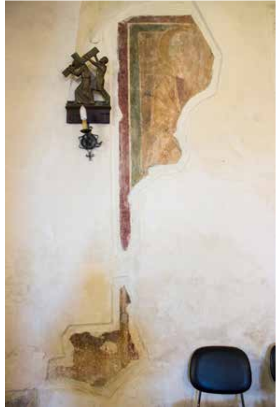
Fig. 2.92 Priverno, chiesa di San Benedetto, navata sinistra, seconda campata, parete sud, santo anziano. (5)
