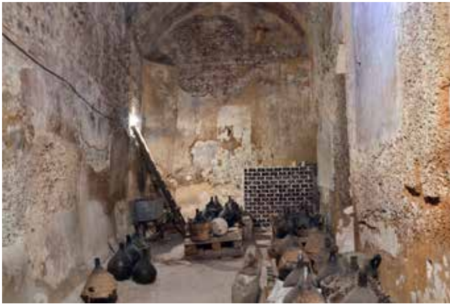
Fig. 2.324 Terracina, chiesa di Santa Maria Maddalena - Villa Salvini, cisterna.
