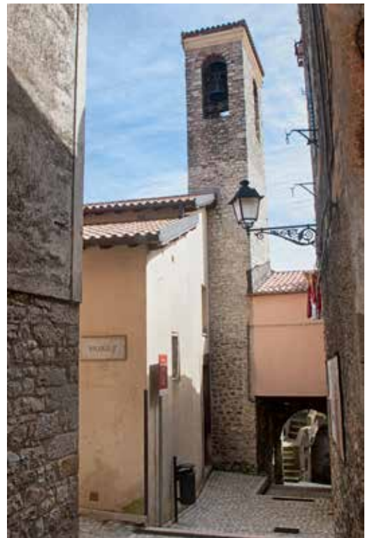
Fig. 2.12 Bassiano, chiesa di San Nicola, facciata e campanile.
