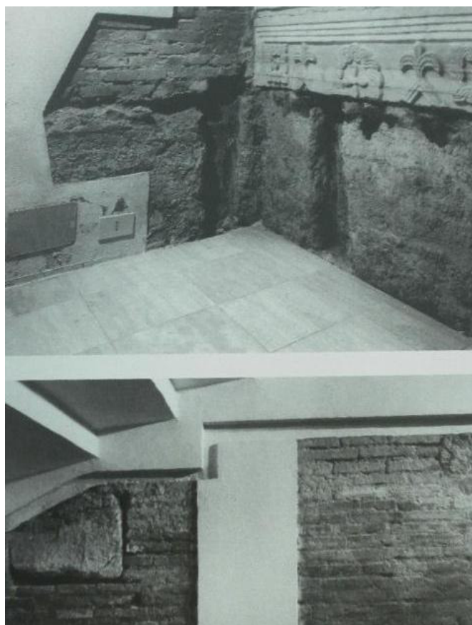
Figura 25 Cripta di S. Maria in Domnica con i resti visibili della Caserma dei Vigili (Caelius I).
