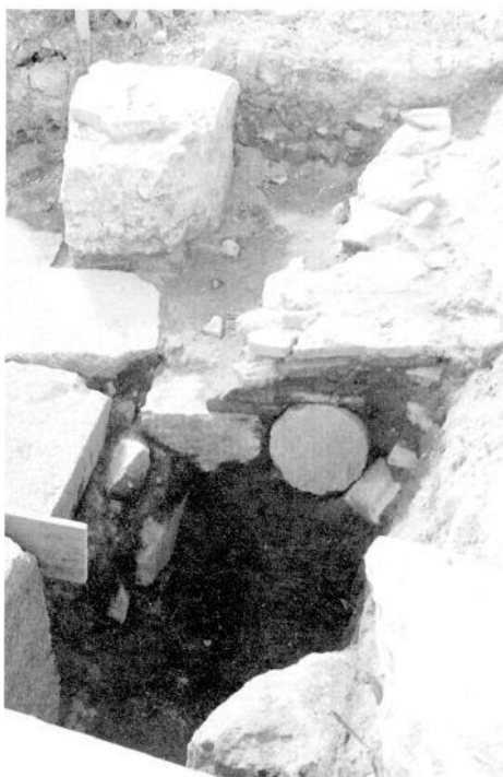
Figura 16 Circo Massimo. Fognolo e pavimentazione in materiali di recupero all'interno dell'arco trionfale
