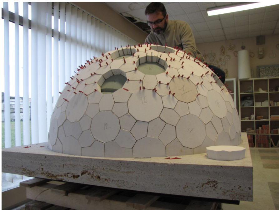
195. Montaggio del prototipo, SNBR, Sainte-Savine, Francia, fotografia
