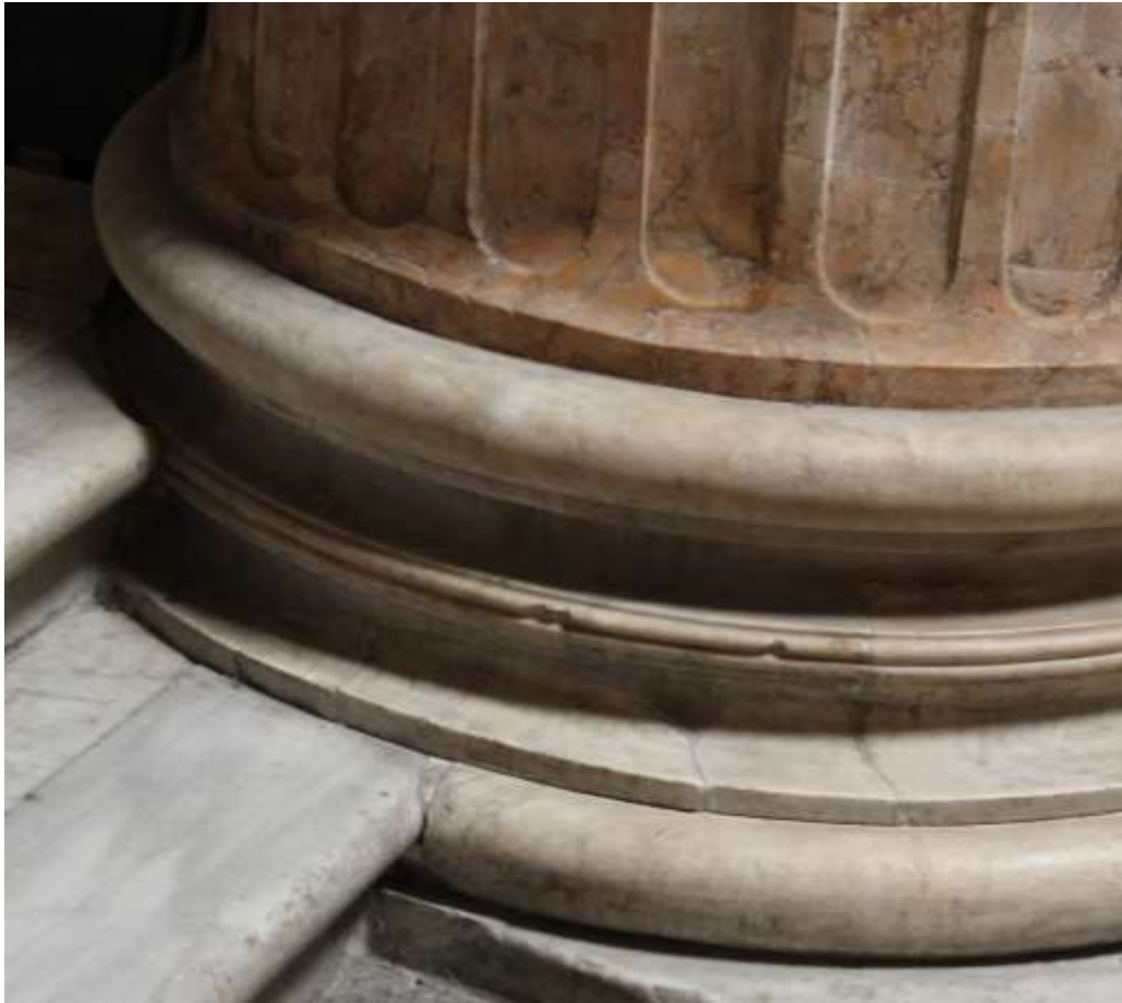
Figura 66 - La base colonna interna oggetto del rilievo fotogrammetrico - Si noti il dettaglio del listello all'imoscapo molto arretrato rispetto al toro della base.
