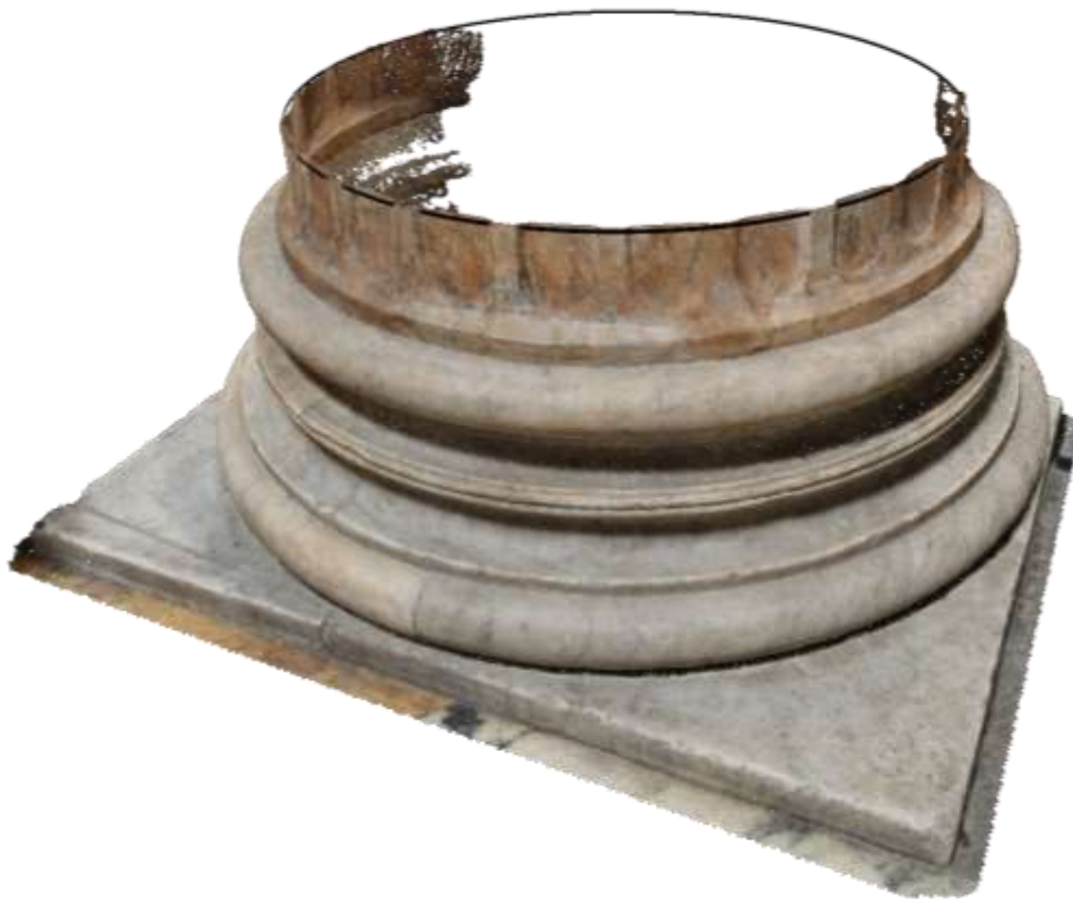
Figura 67 - Vista prospettica della nuvola di punti fotogrammetrica con l'estrazione della circonferenza all'imoscapo.
