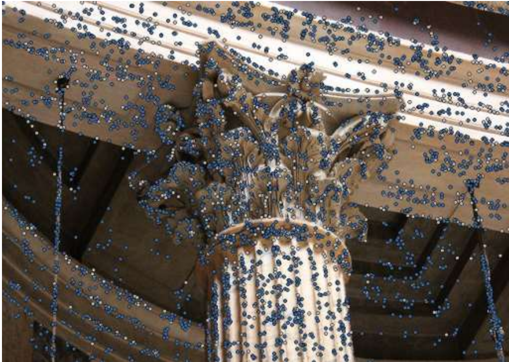
Figura 11 - Visualizzazione dei tie point su una delle foto del rilievo fotogrammetrico - In blu i punti che hanno una corrispondenza in altre foto.
