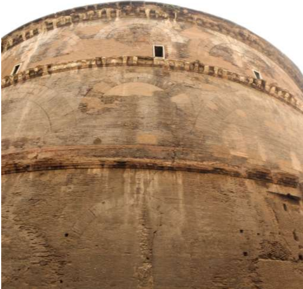
Figura 10 - Prospetto ovest - Il prospetto esterno è scandito da tre cornici orizzontali, e ospita grandi archi di mattoni bipedali corrispondenti agli ambienti ricavati nello spessore del muro.
