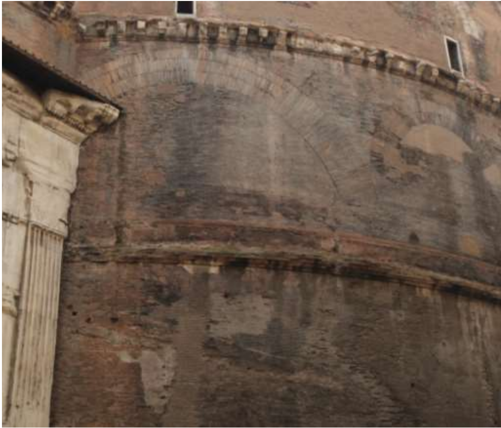
Figura 57 - Prospetto ovest - Nella muratura del secondo livello si notino gli archi tre ghiere affiancati da quelli a due ghiere.
