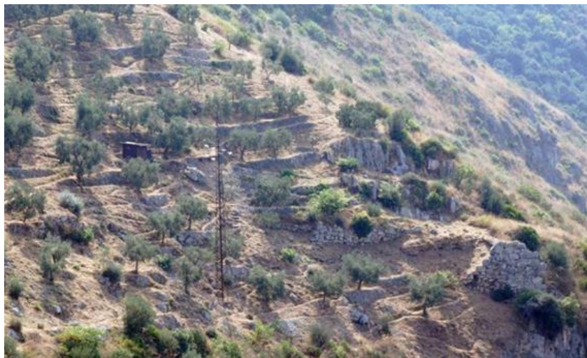
Fig 9.17 – Le poche tracce sopravvissute dei primitivi terrazzamenti realizzati ai piedi dell'acropoli dell'antica Norba fanno ben comprendere quale dovesse essere la loro imponenza originaria (Gruppo di Ricerca GECOAGRI-LANDITALY, foto G. Esposito).
