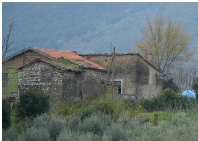
fig 7.4 - Casa rurale complessa nella Valle del Rio composta da elementi originari in pietra ed elementi giustapposti più recenti in tufo (Gruppo di Ricerca GEORGRI-LANDITALY, foto G. Esposito)
