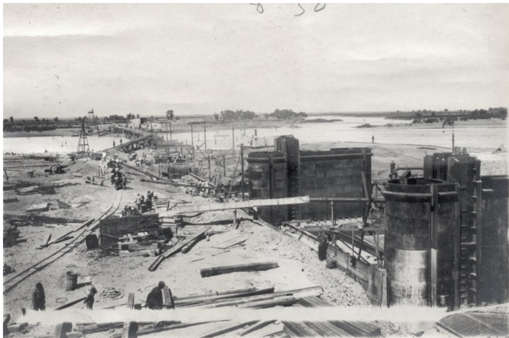
Figura 9.10 La costruzione del ponte sul fiume Neuquén ( http://museodelriego.gob.ar/ )
