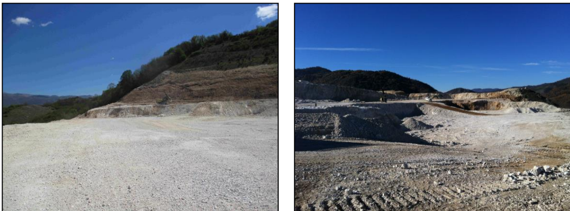
Fig. 227: visuale del piazzale di cava oggetto della campagna di misurazione
