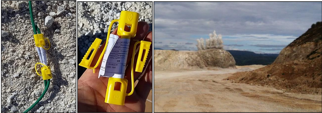
Fig. 256: relais impiegato nella volata e brillamento dell'esplosivo
