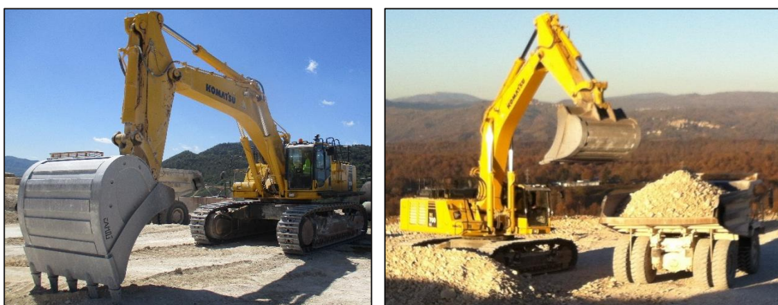
Fig. 17: visuale dell'escavatore (sinistra) e caricamento su mezzo LHD (destra)
