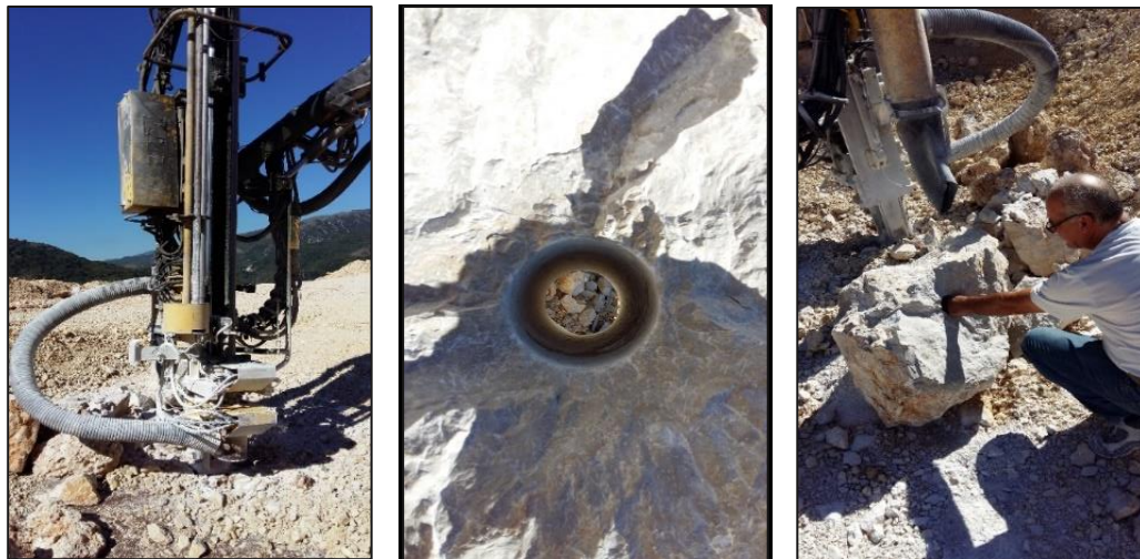
Fig. 22: realizzazione della prova di perforazione(sinistra), visuale della precisione del foro (centro) e dimensioni (destra)
