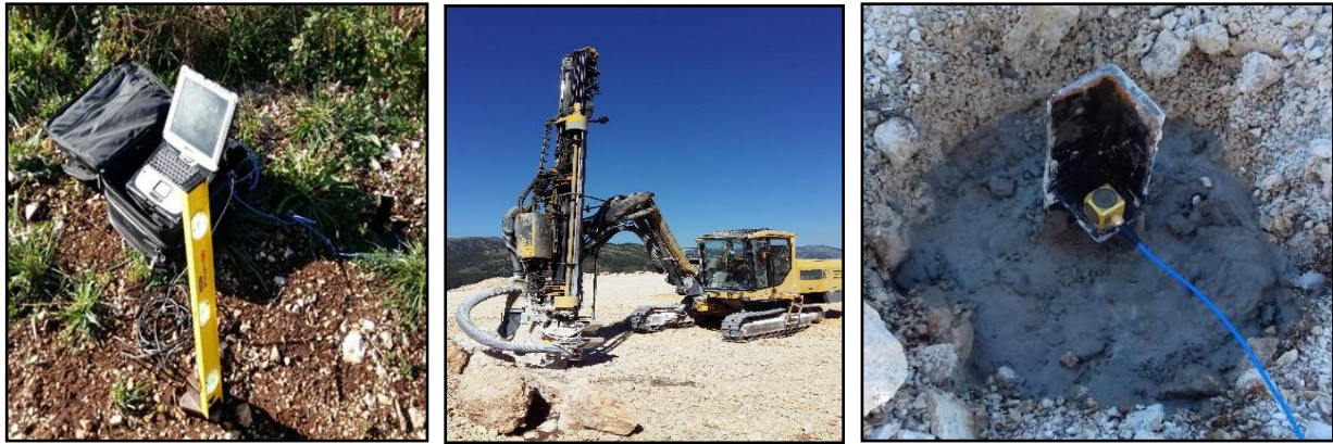
Fig. 280: verifica del corretto allineamento (sinistra), realizzazione foro (centrale) e profilato immobilizzato con il cemento (destra)
