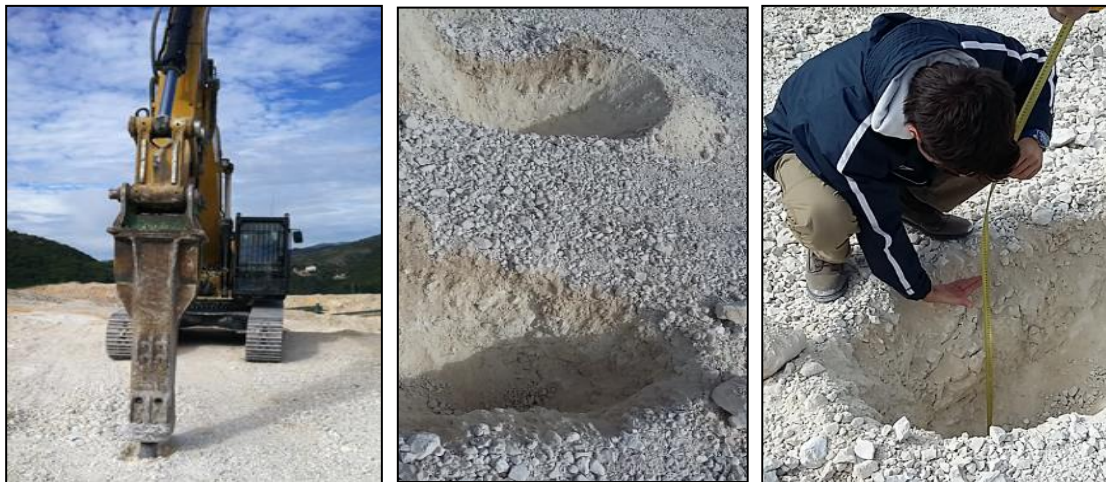
Fig. 253: realizzazione del foro con martello demolitore e verifica della profondità
