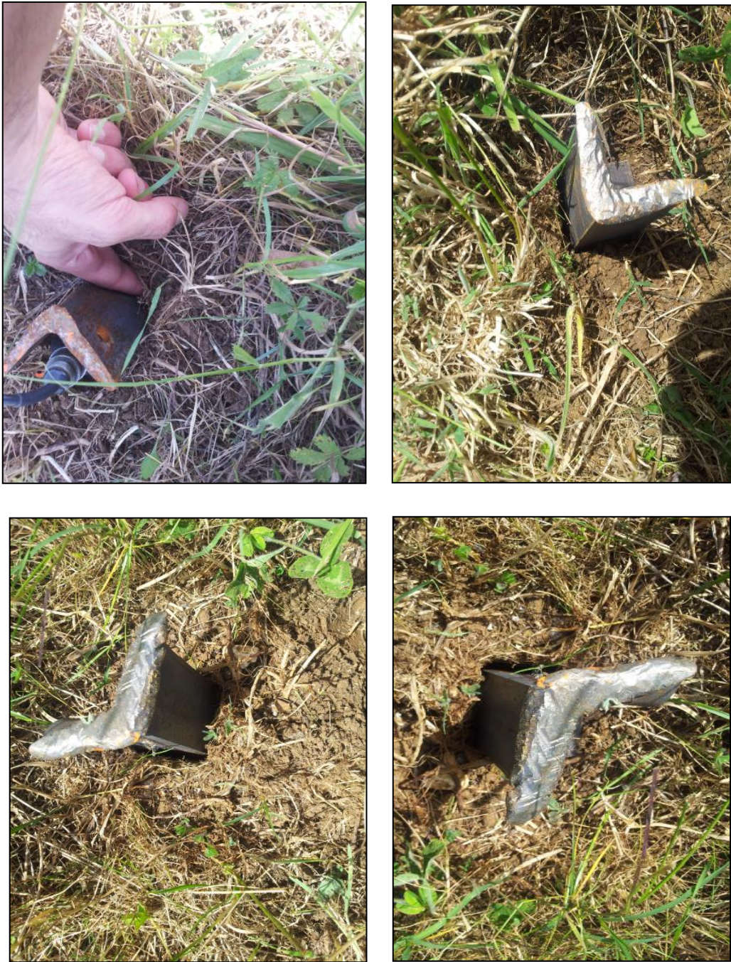
Fig. 221: distacco del palo dal terreno
