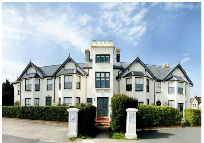
Figg. 3.12 e 3.13 - Dimbola Lodge come appare oggi (luglio 2017)
