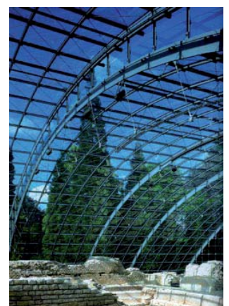
7. La struttura protettiva vista dall'interno, con il sistema di velari che calibrano la luminosità interna. 8. Lo spazio interno dalla vetrata di accesso. 9. L'estrema permeabilità visiva tra interno ed esterno.
