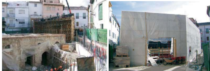
9-10. Due fasi dell'esecuzione del muro perimetrale del nuovo contenitore.
