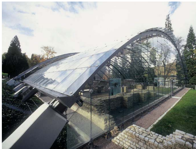
4. La copertura costruita nel 2001. In evidenza l'attacco della struttura a terra e il sistema delle vetrate. 5. L'intervento inserito nel paesaggio. 6. L'esterno della struttura.
