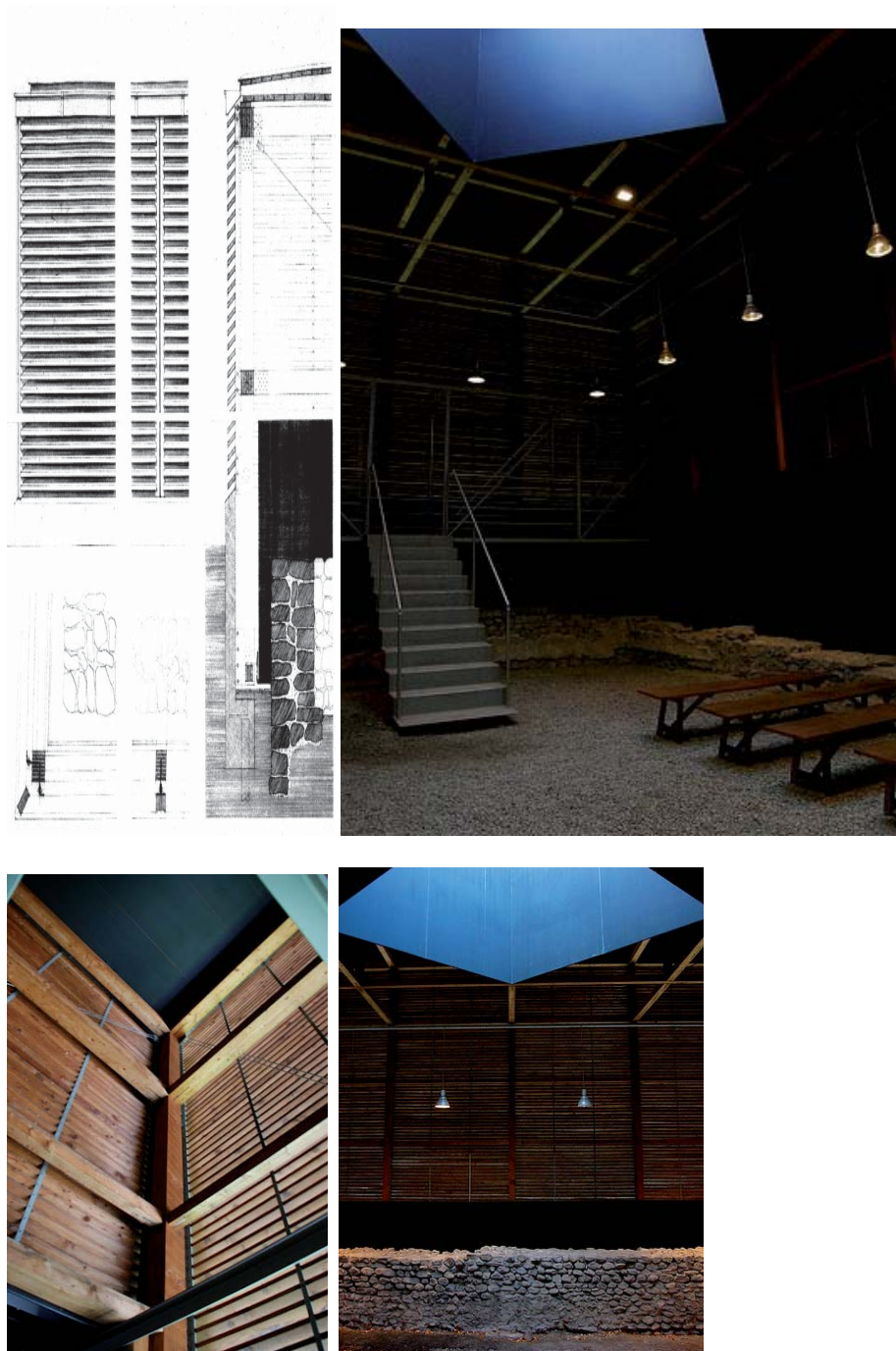
8. dettaglio del sistema di sostegno e della tamponatura lignea; 9-10-11 viste interne dell'ultima sala dove è possibile scendere al livello romano.
