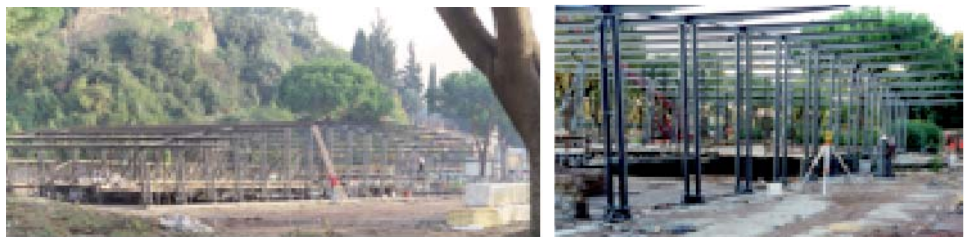
14-15. Alcune fasi del montaggio del telaio metallico.
