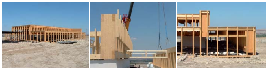
12-13.14. sequenza di alcune fasi montaggio dell'orditura in legno lamellare.
