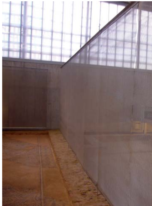
8. Fotografia interna dalla passerella verso l'oculus 9. Particolare del diaframma in maglia metallica utilizzato come quinta per dividere gli ambienti della villa
