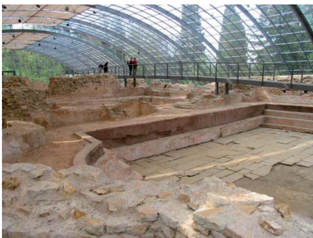
7. La struttura protettiva vista dall'interno, con il sistema di velari che calibrano la luminosità interna. 8. Lo spazio interno dalla vetrata di accesso. 9. L'estrema permeabilità visiva tra interno ed esterno.
