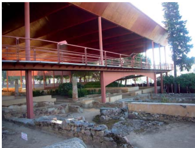
9. La copertura archeologica vista dall'esterno. In evidenza il sistema degli appoggi
