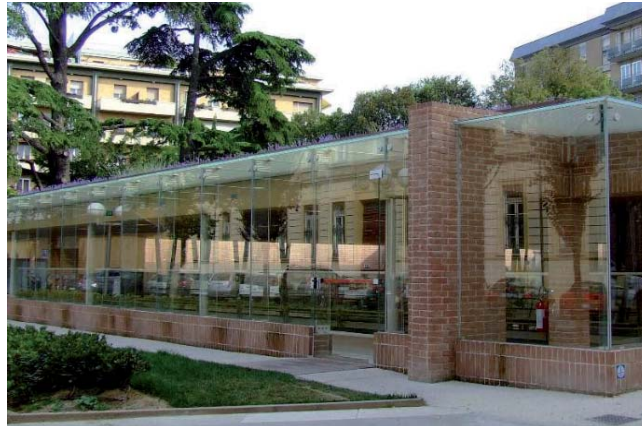
11 Lo spazio interno ed i reperti protetti. 12. L'estradosso della copertura della protezione archeologica. 13. L'ingresso all'area archeologica.
