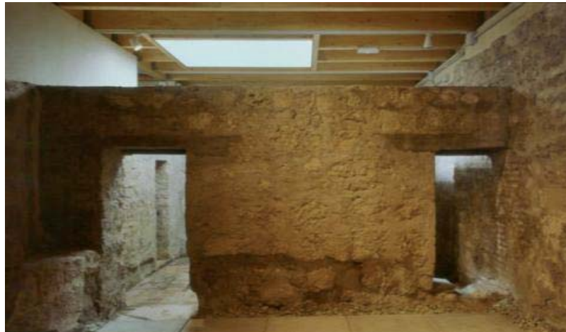
3. Vista da Nord-Ovest della tetto-terrazza; 4. Vista da Nord-Ovest della tetto-terrazza;
