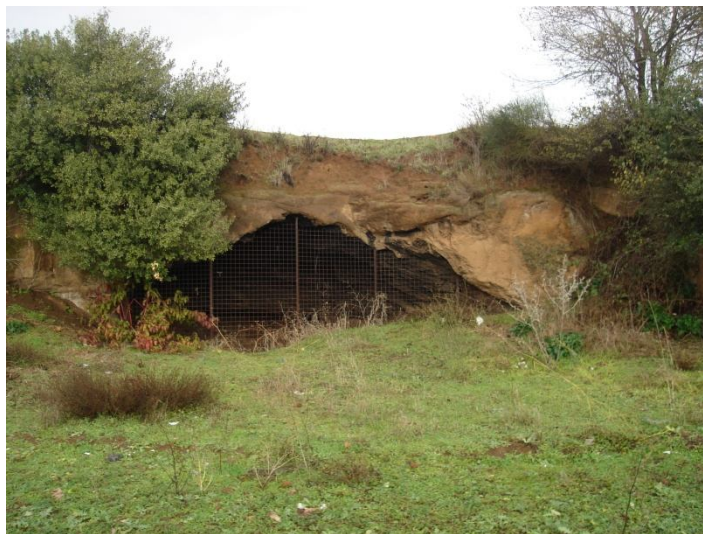
Figura 12. Ingresso di una cava abbandonata in valle della Caffarella, scavata nell'unità eruttiva di "Villa Senni".
