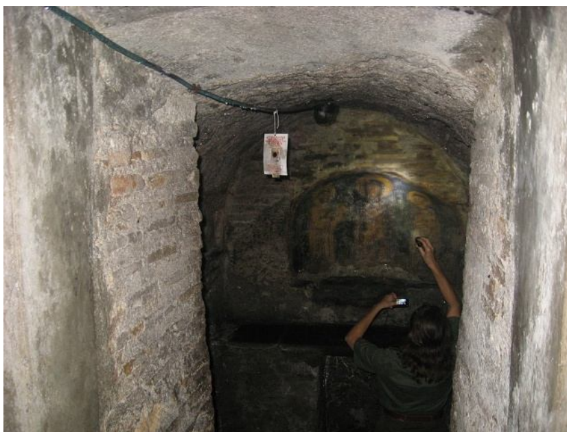
Figura 46. Monitoraggio della concentrazione di radon nella cripta sotterranea di una chiesa (DOS23).
