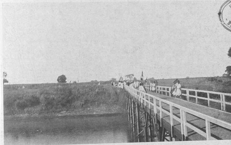
Inaugurazione del primo ponte sull' Uebi Scebeli. (Neg. Costa).
