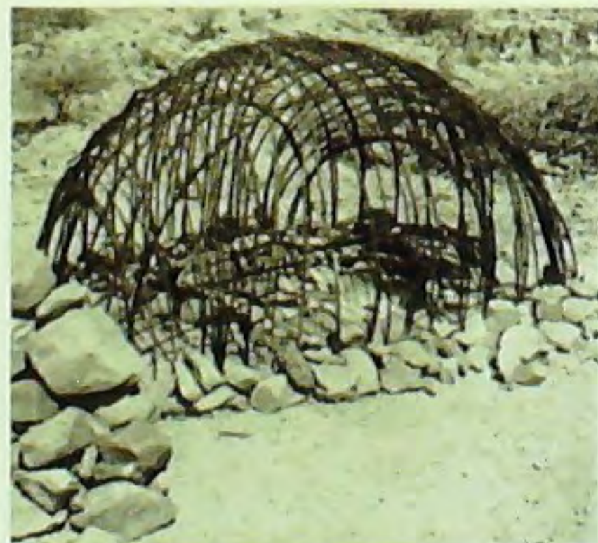
TENTE DANKALIE EN CONSTRUCTION A GABLA-HAFA, dans la vallée de l'oued Mabdahou (Songho- Goudha). Les arceaux de bois formant l'arma- ture de la tente sont plantés dans le sol et leur base consolidée par un petit mur de pierres.
