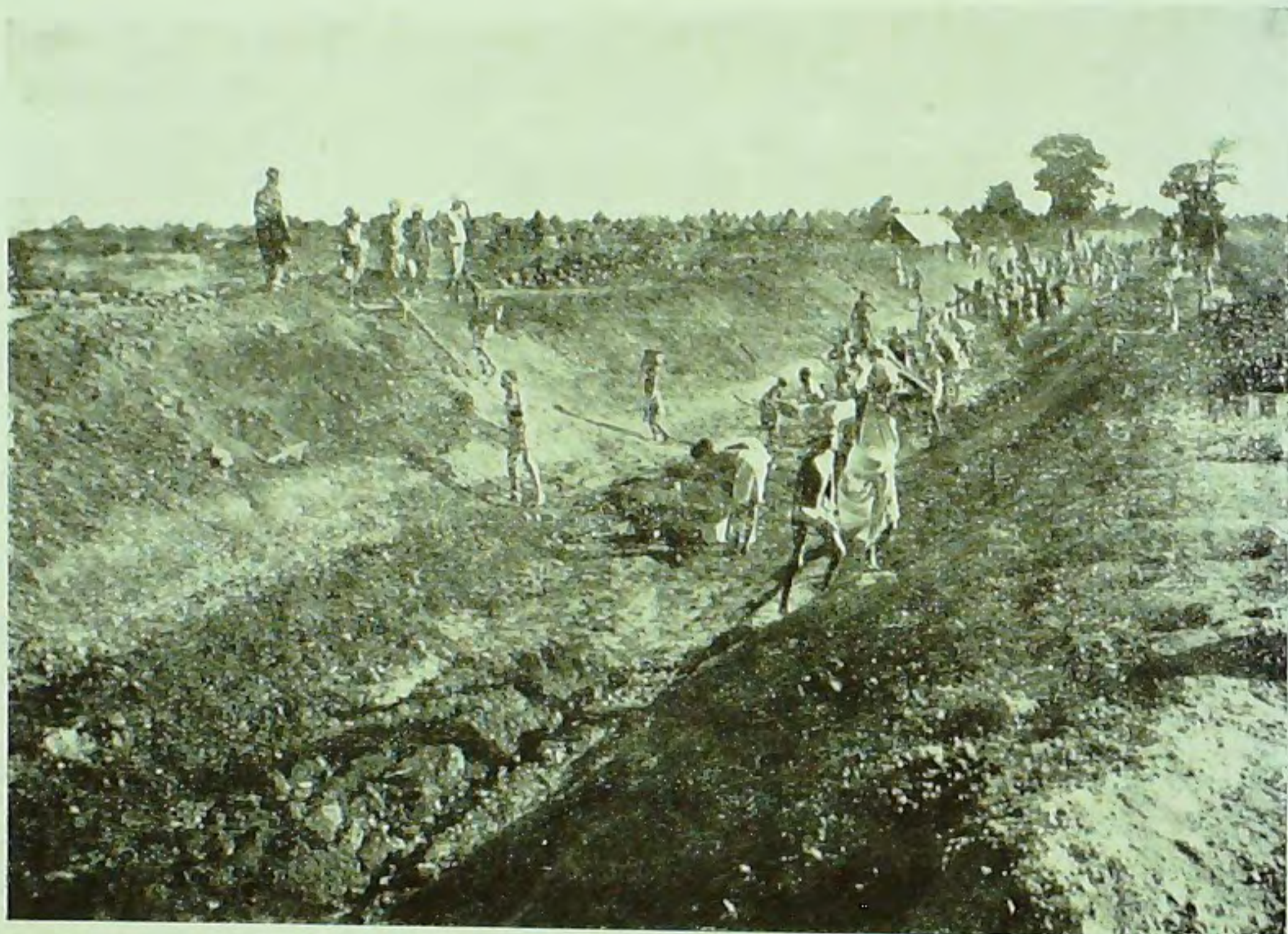
GENALE - Costruzione d'un canale secondario.
