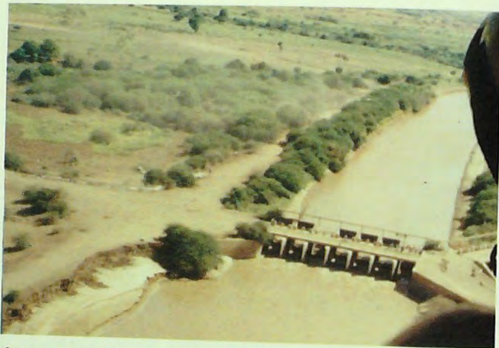
La grande diga di Jowhar in una veduta aerea.
