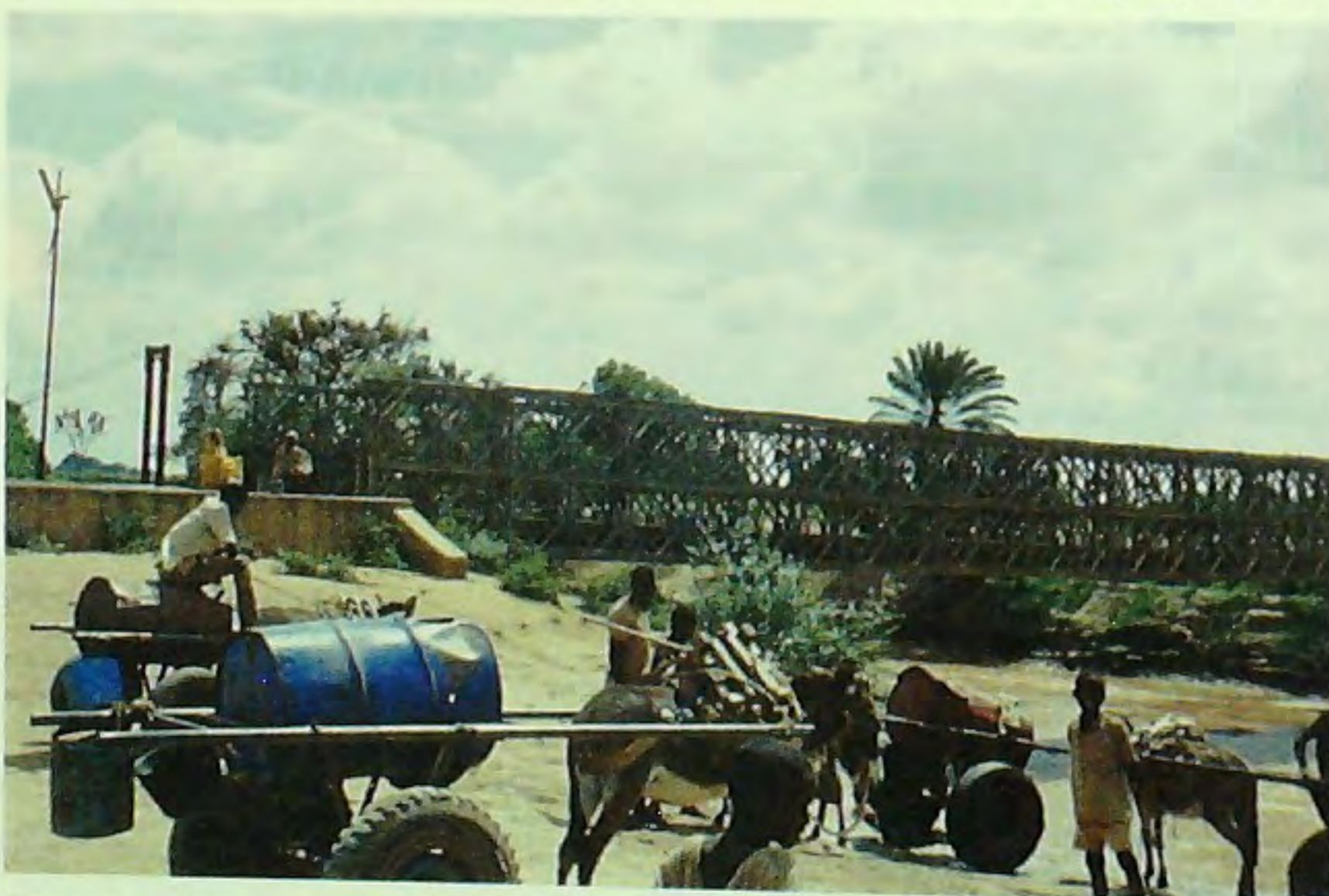
Il ponte sul fiume Uebi Scebeli a Gialalassi.
