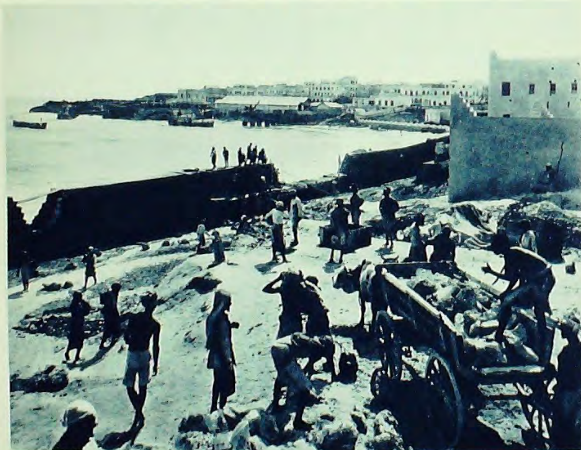
Fig. 114 - Costruzione del lungo mare « Vittorio Bottego » a Mogadiscio (1926-IV)
