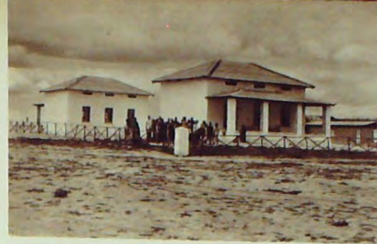
Construction pour école primaire à El Bur
