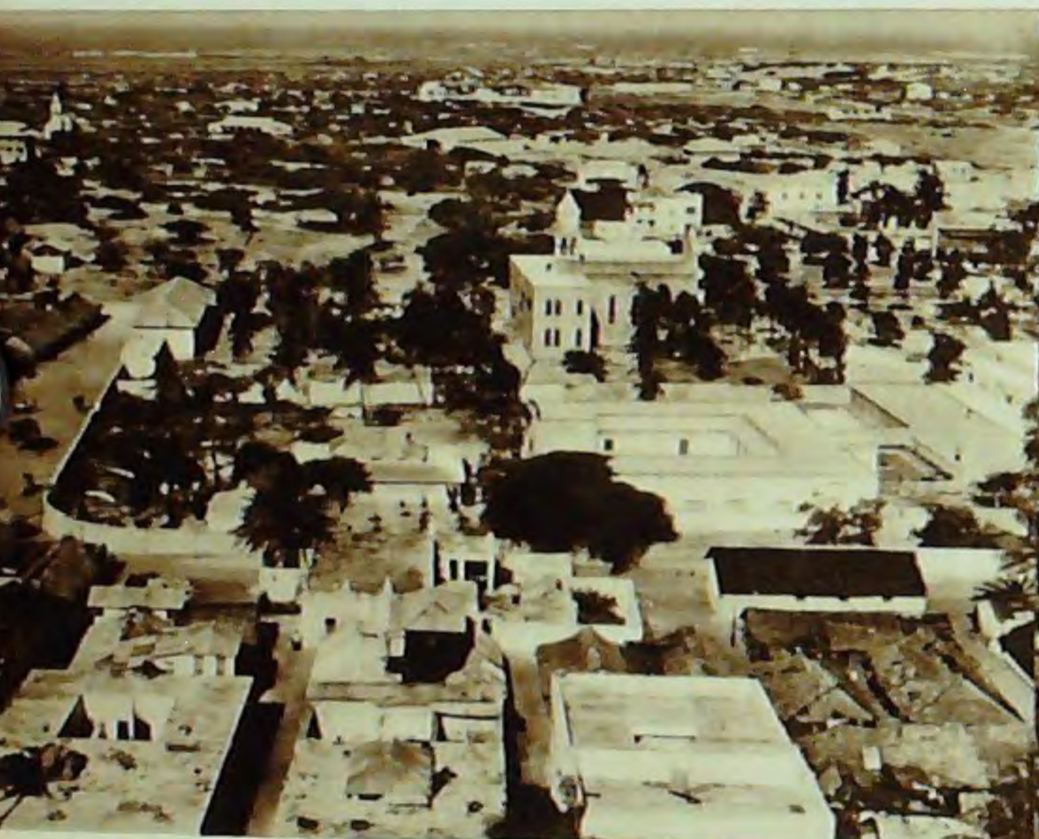
A Chisimaio, on a réalisé quelques importantes constructions pendant l'année
