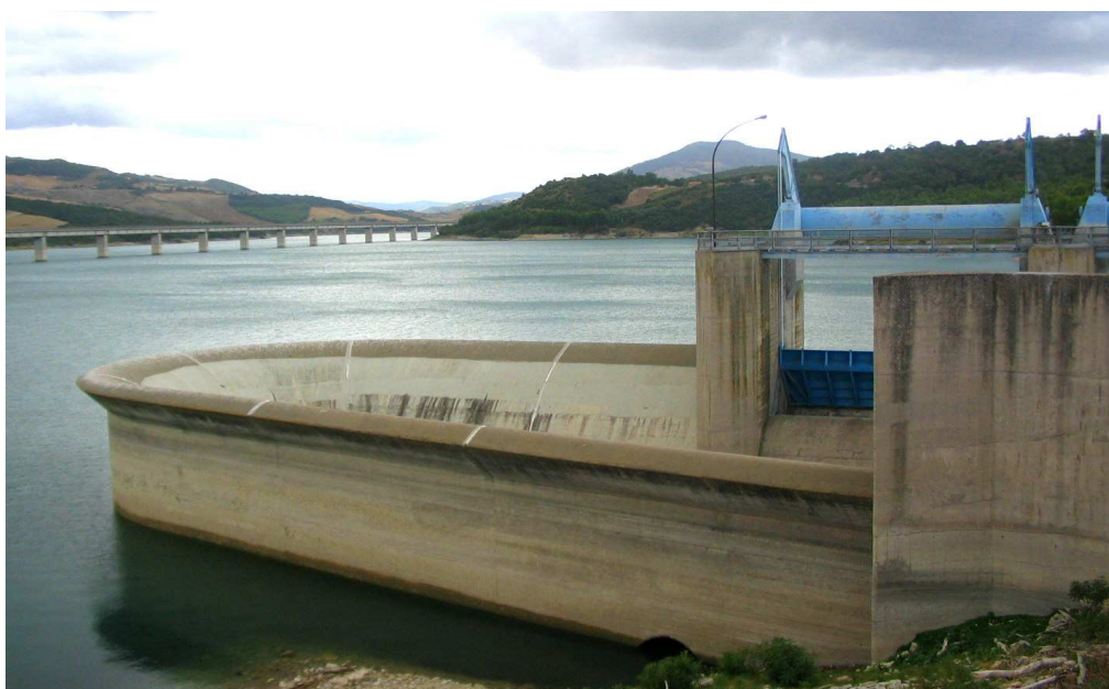
Fig. 56 Scarico di superficie sviluppato ad U aperta e zoppa (foto L. Mastroberardino)
