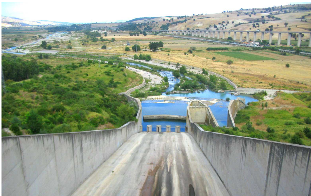
Fig. 58 Canale di scarico che conduce le acque alla vasca di dissipazione (foto L. Mastroberardino)
