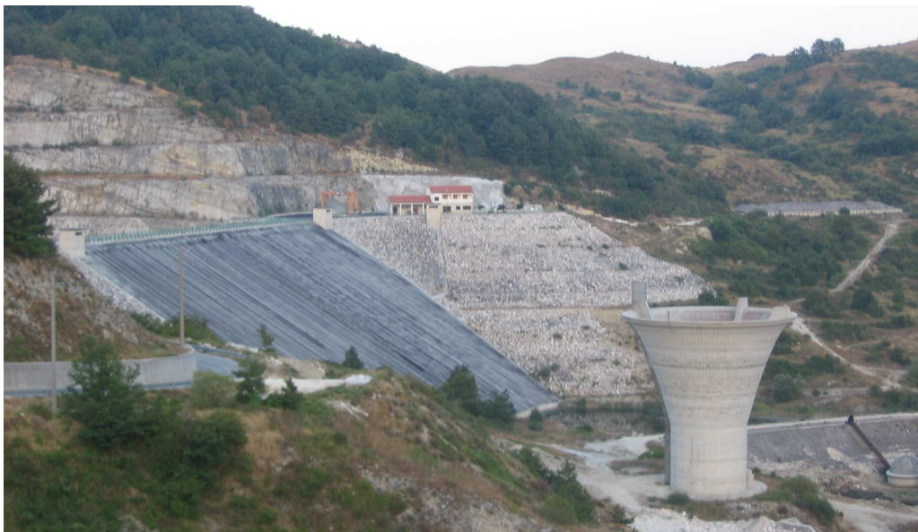
Fig. 51 La diga di Chiauci nel bacino del fiume Trigno (foto L. Mastroberardino)
