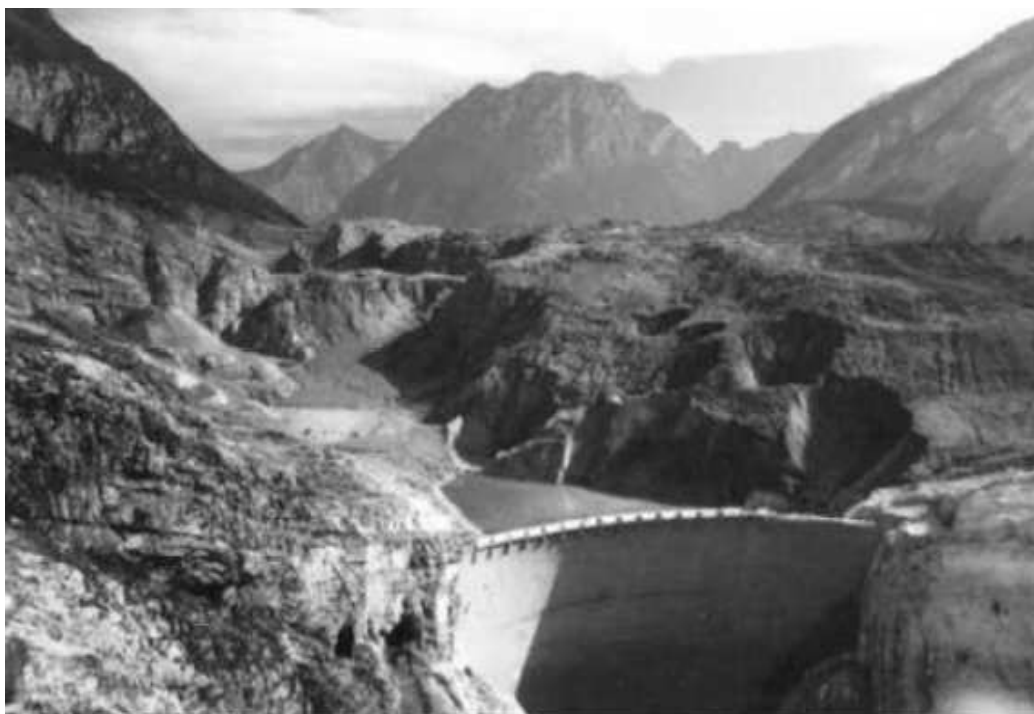
Fig. 23 La diga del Vajont ( Fonte: Leone U. ,2008, le dighe, p.214)
