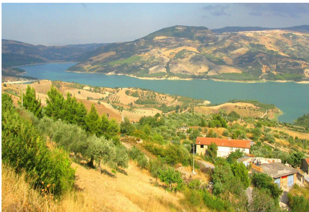
Fig.50 Il Lago di Occhito costruito con i finanziamenti CASMEZ (foto A. Mastroberardino)
