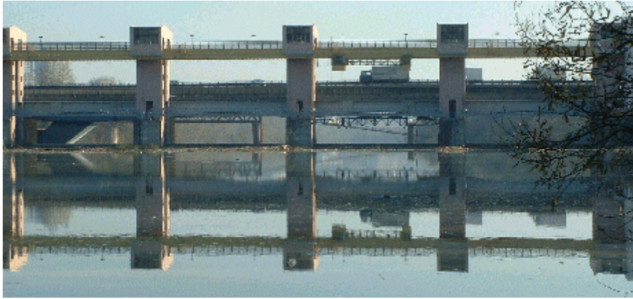
Fig. 20 Diga di Castel Giubileo (RM) è una traversa in calcestruzzo (fonte: www.registroitalianodighe.it )
