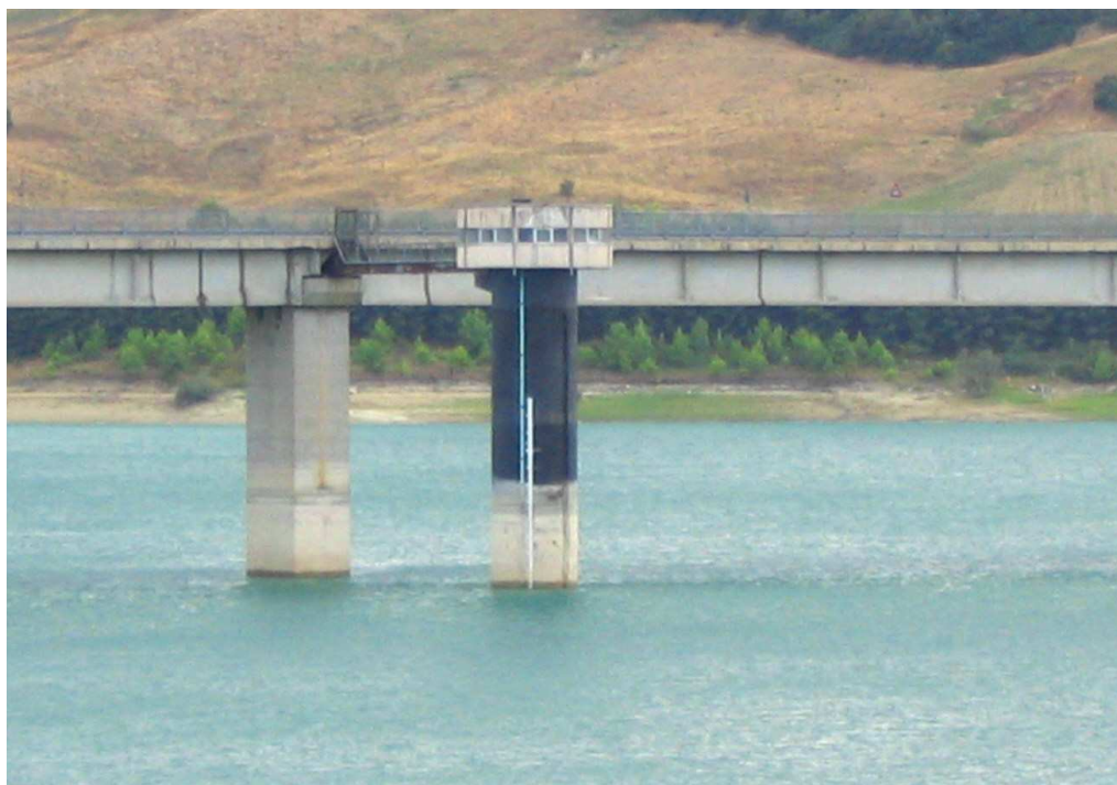
Fig.59 Torrino di presa dell'acqua che viene inviata al potabilizzatore (foto L.Mastroberardino)
