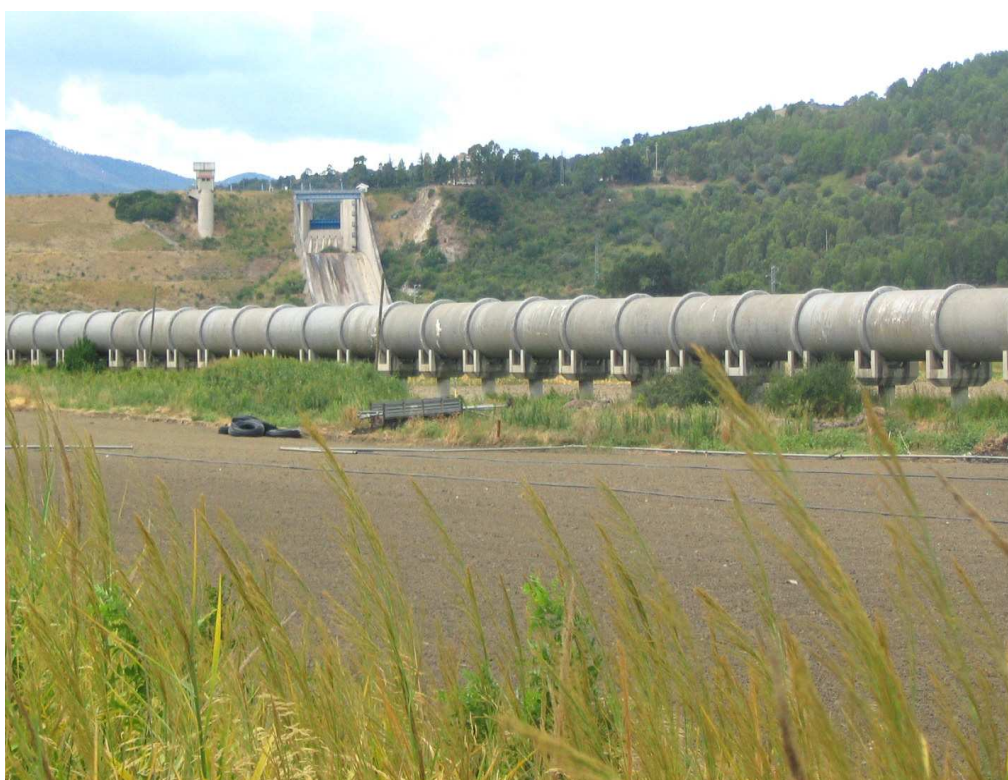
Fig. 61 Adduttore irriguo-industriale (foto L. Mastroberardino)
