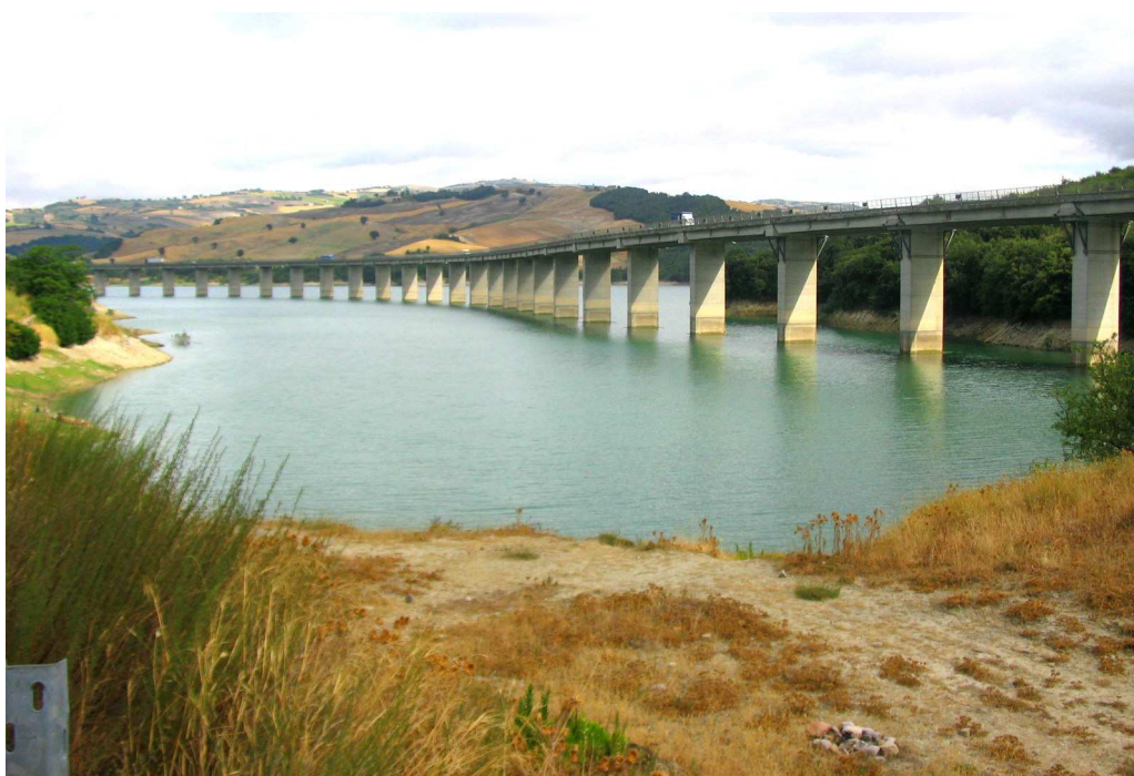
Fig. 47 La Strada Statale 657 Bifernina costruita con il finanziamento CASMEZ in seguito alla realizzazione del Lago di Guardialfiera (foto L. Mastroberardino)
