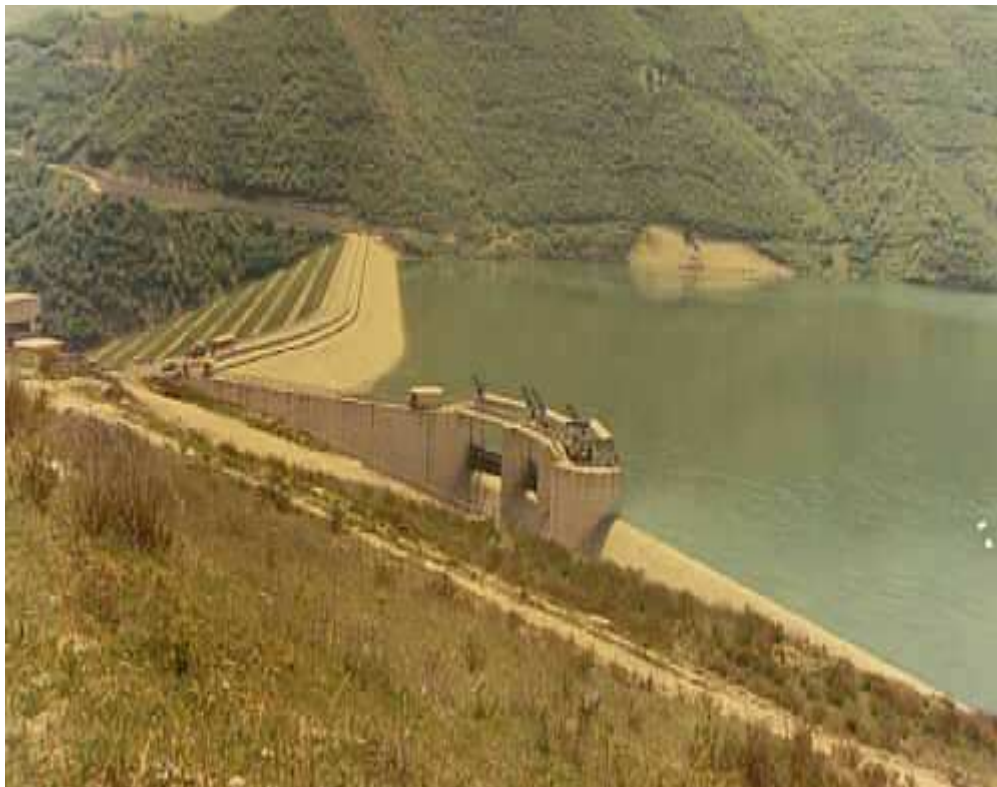
Fig. 45 La diga di Occhito (Fonte: www.consorziobonificafg.it )
