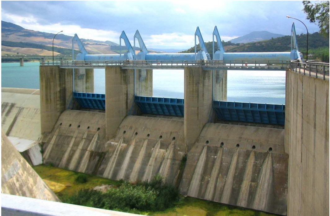
Fig. 57 Scarico di superficie con paratoie a ventola (foto L. Mastroberardino)
