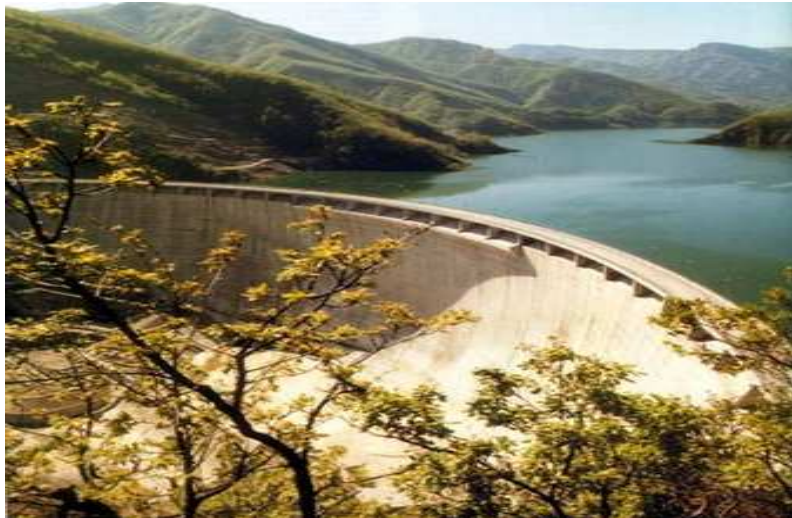
Fig. 17 Diga di tipo arco/gravità di Ridarcoli- Santa Sofia (Forlì) (Fonte: www.registroitalianodighe.it )
