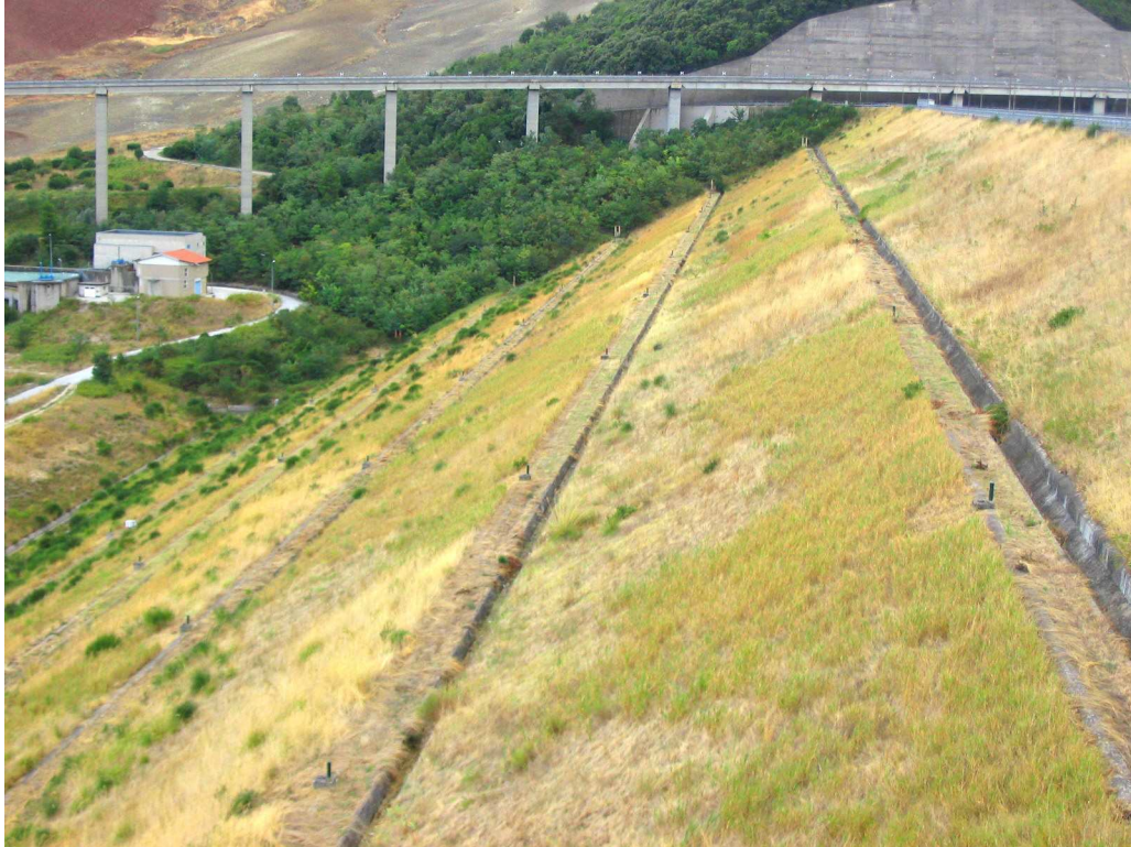
Fig. 70 Parametro a gradoni della diga a valle rivestito da un manto erboso (foto L. Mastroberardino)
